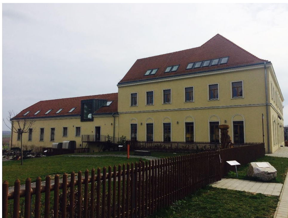
Obrázek 6: Budova Ekocentrum Trkmanka ve Velkých Pavlovicích (ZDROJ: Lucie Pokorná)
