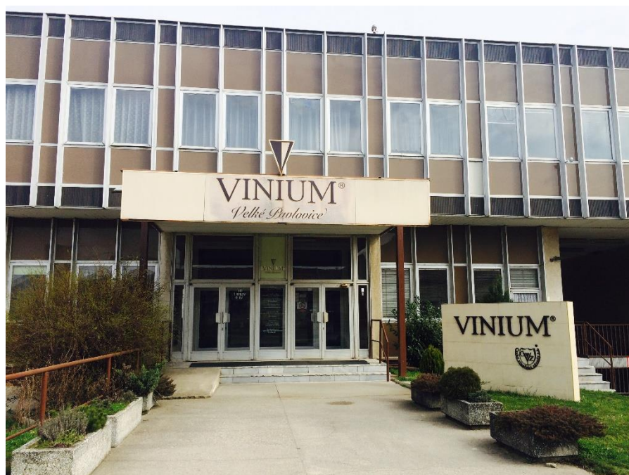
Obrázek 5: Budova Vinium a.s., Velké Pavlovice (ZDROJ: Lucie Pokorná)
