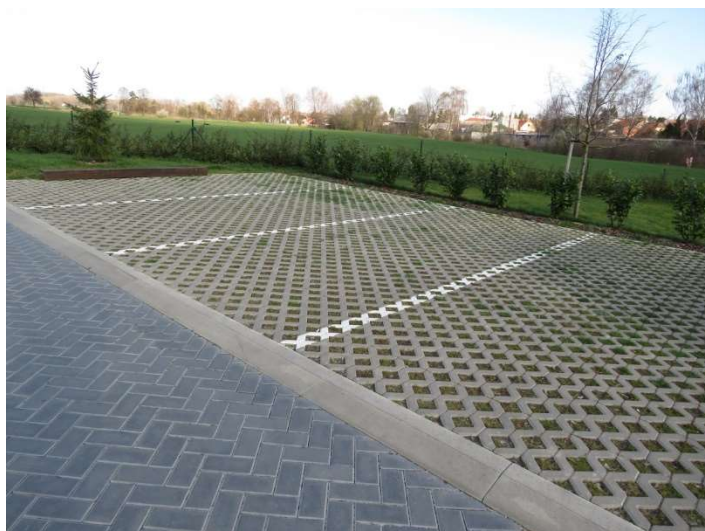
Obr. 6: Polopropustný povrch, který byl použit na parkoviště, Praha – Čakovice (zdroj: fotoarchiv autorky, 2020)
