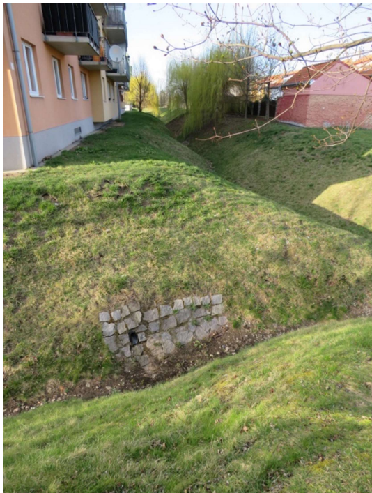
Obr. 22: Odvodnění střech bytových domů, Praha (zdroj: fotoarchiv autorky, 2020)
