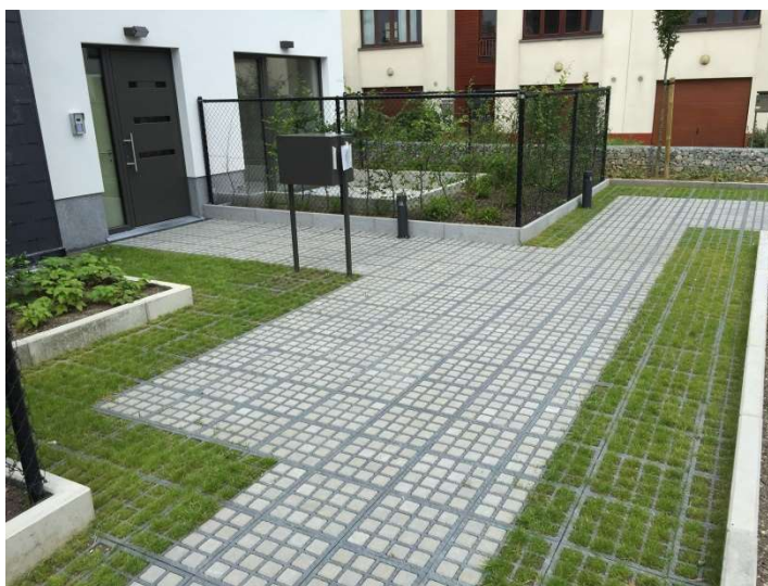
Obr. 25: Zasadovací rošty (zdroj: asio.cz)
