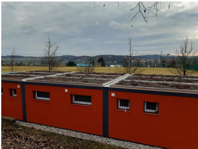
Obr. 28: Částečná zatravněná střecha buněk v Brně (zdroj: fotoarchiv autorky, 2020)
