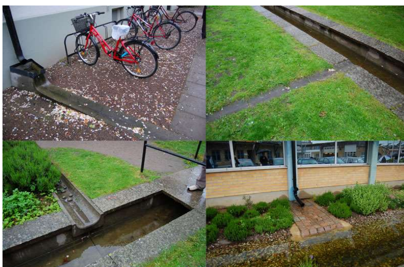
Obr. 31: Otevřené kanály kam jsou svedeny vody ze střech (zdroj: urbanreport.wordpress.com)
