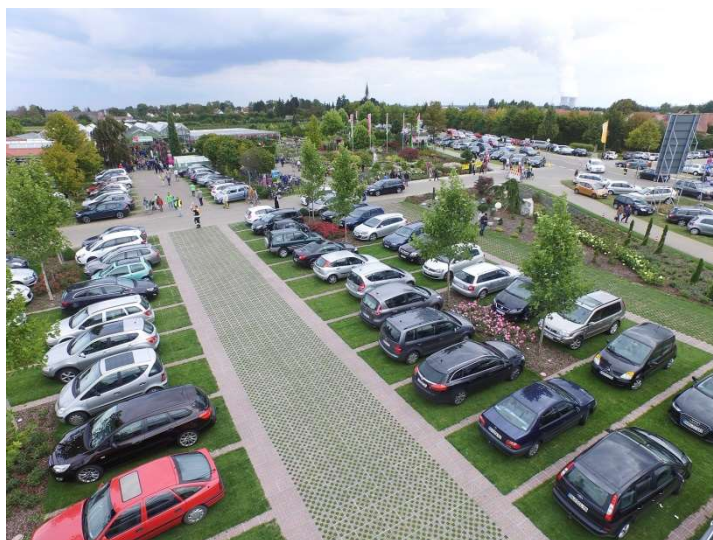
Obr. 26: Využití AS-TTE roštů na parkovišti (zdroj. asio.cz)
