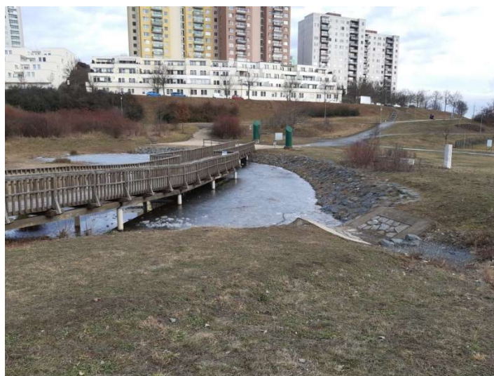
Obr. 23: Odvodnění střech panelových domů do jezírka v Parku pod Plachtami (zdroj: fotoarchiv autorky, 2020)
