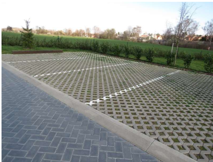
Obr. 5: Polopropustný povrch, který byl použit u parkoviště, Praha (zdroj: fotoarchiv autorky, 2020)
