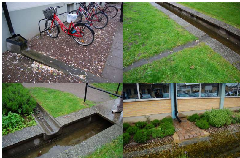
Obr. 17: Otevřené kanály, kam jsou svedeny vody ze střech (zdroj: urbanreport.wordpress.com )
