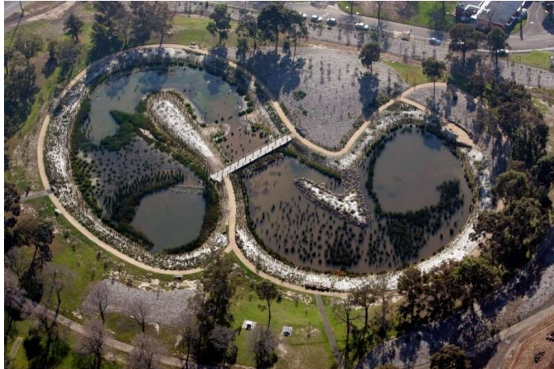
Obr. 20: Dešťová voda se čistí, když protéká rostlinami v mokřadu ve tvaru S (zdroj: urbanwater.melbourne.vic.gov.au )
