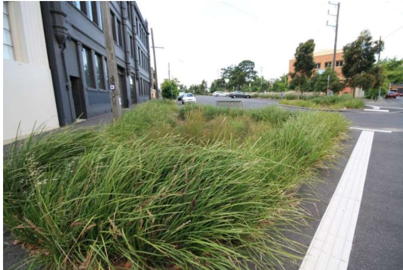
Obr. 19: Howard Street raingardens (zdroj: urbanwater.melbourne.vic.gov.au)
