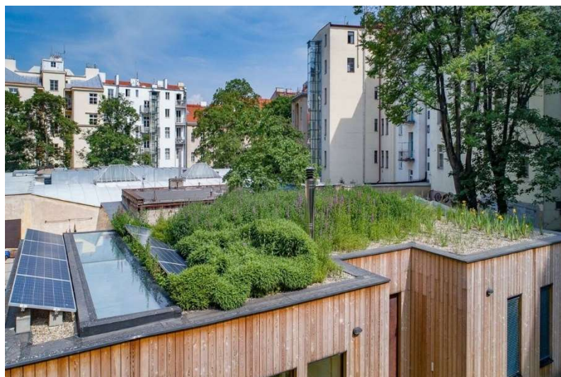
Obr. 16: Dům s mokřadní střechou, Praha (zdroj: adaptterraawards.cz)
