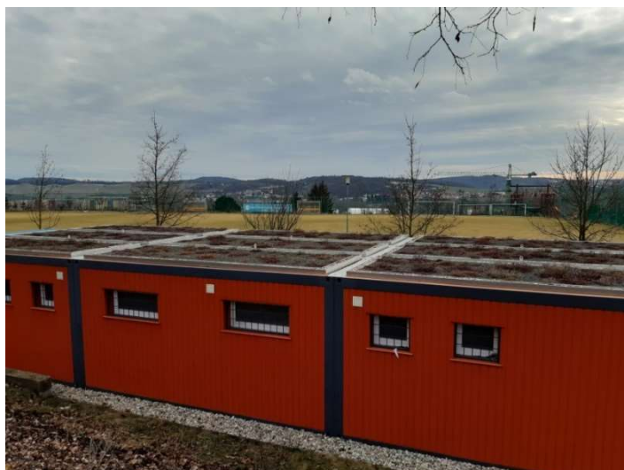
Obr. 15: Částečná zatravněná střecha buněk v Brně (zdroj: fotoarchiv autorky, 2020)
