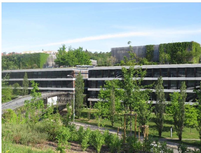
Obr. 14: Zelená střecha na budově ústředí ČSOB v Radlicích, Praha (zdroj: fotoarchiv autorky, 2020)
