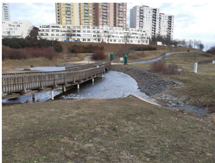
Obr. 10: Odvodnění střech panelových domů do jezírka v Parku pod Plachtami, Brno (zdroj: fotoarchiv autorky, 2020)
