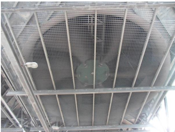
Obr. 3.11 Kondenzátor SAKO Brno – axiální ventilátor
