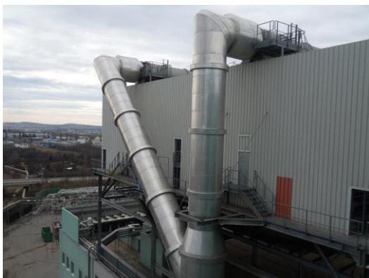
Obr. 5.4 Dvě větve potrubí DN 1700
