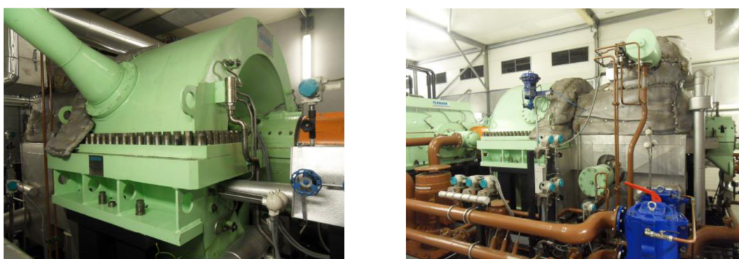
Obr. 5.1 Turbína 22,7 MW Sako Brno
