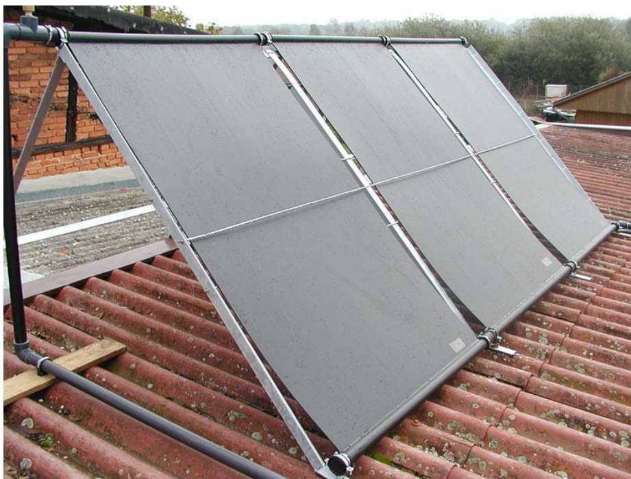
Obr. 4 Absorbér k ohřevu vody v bazénu [24]
