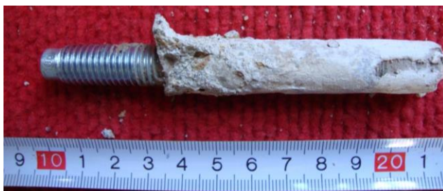
Obrázek 70 – Kotva 1, nevyčištěná, hloubky 70 mm
