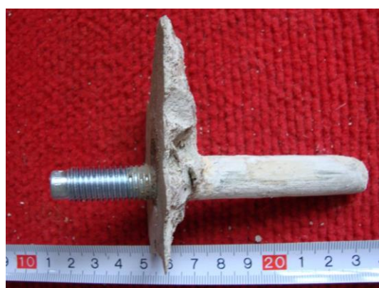
Obrázek 72 – Kotva 3, nevyčištěná, hloubky 70 mm
