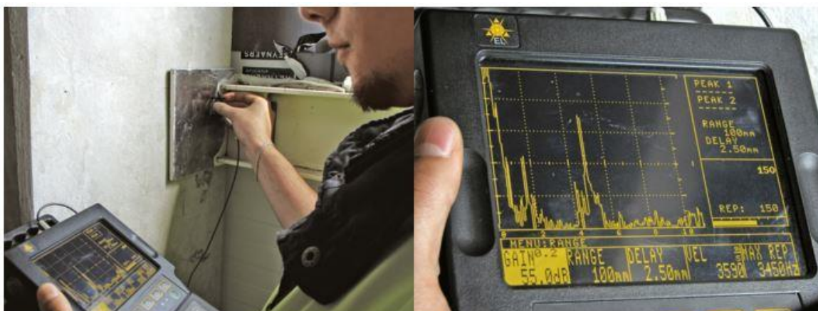
Obrázek 25 – Ověření ukotvení táhlových přípojek
