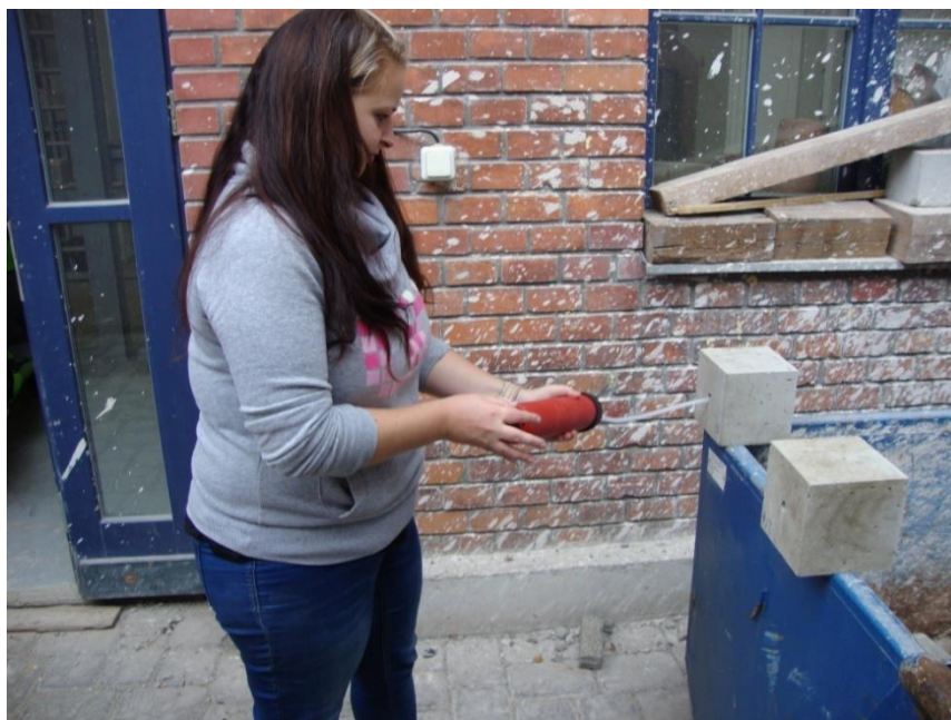
Obrázek 50 – Vyčištění otvoru pomocí ruční pumpy
