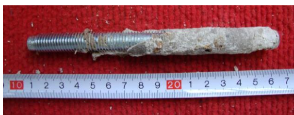
Obrázek 65 – Kotva 2, vyčištěná, hloubky 110 mm
