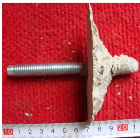
Obrázek 59 – Kotva 3, vyčištěná, hloubky 40 mm
