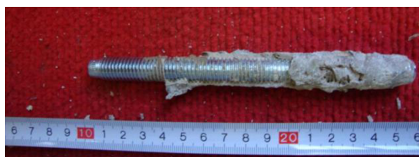
Obrázek 66 – Kotva 3, vyčištěná, hloubky 110 mm
