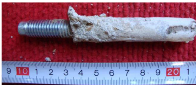
Obrázek 70 – Kotva 1, nevyčištěná, hloubky 70 mm
