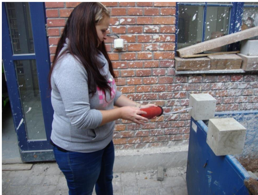
Obrázek 50 – Vyčištění otvoru pomocí ruční pumpy
