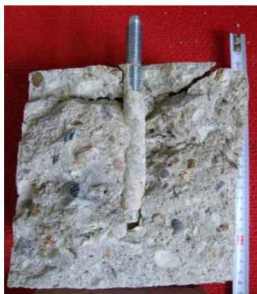
Obrázek 75 – Kotva 3, nevyčištěná, hloubky 110 mm
