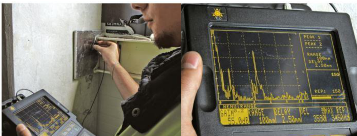
Obrázek 25 – Ověření ukotvení táhlových přípojek
