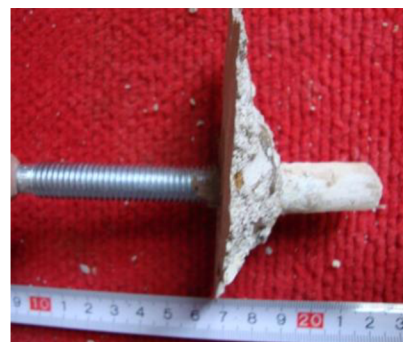
Obrázek 68 – Kotva 1, nevyčištěná, hloubky 40 mm
