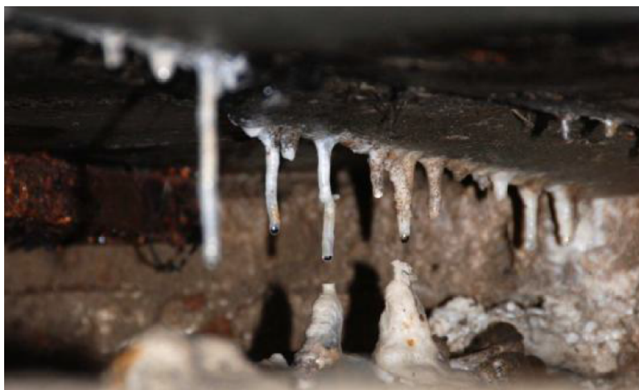
Obrázek 3.3: Pohľad na inkrustácie v pozdĺžnej špáre medzi nosníkmi [11]
