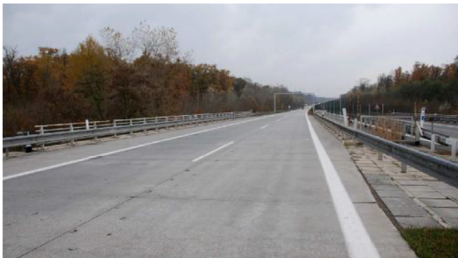
Obrázek 3.2: Ľavý most ev.č. D2-055..2 cez kanál a lesnú cestu za obcou Lanžhot [11]
