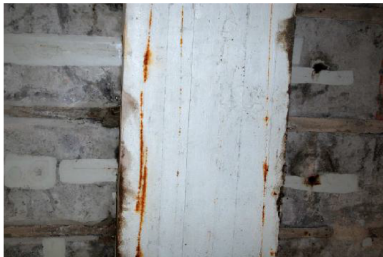
Obrázek 3.4: Odvodňovacie otvory prekryté sanačným náterom [11]
