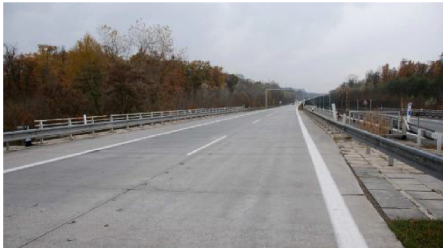
Obrázek 3.2: Ľavý most ev.č. D2-055..2 cez kanál a lesnú cestu za obcou Lanžhot [11]
