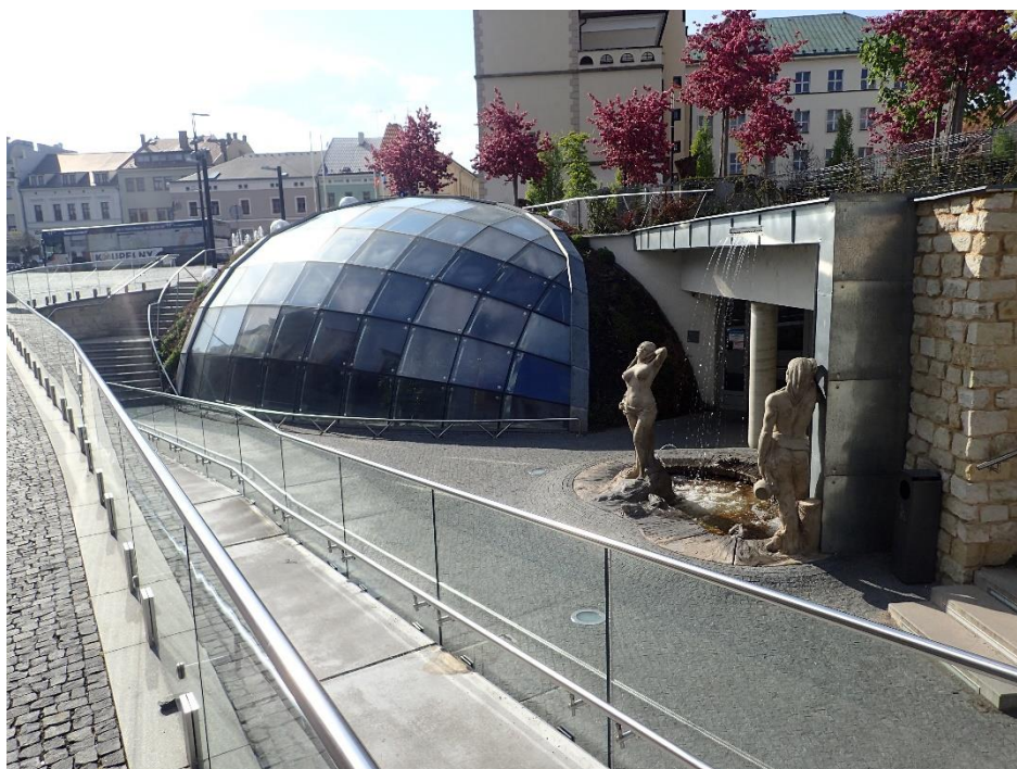
Fotografie 16 – Budova podzemního parkoviště
