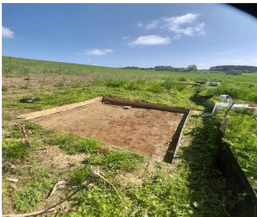
Obr. 11 - stav sedimentační jímky č. 2 po opravě (vlastní foto, 5/2023)
