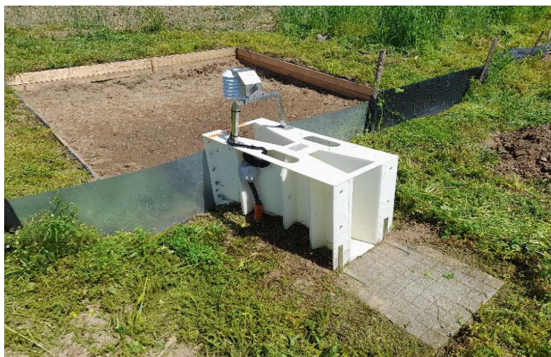
Obr. 13 – opravený a vyčištěný Parshallův žlab (vlastní foto, 5/2023)
