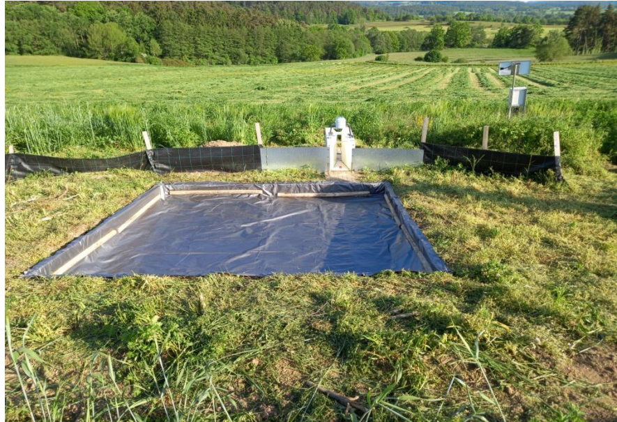
Obr. 6 - detail sedimentační jímky s vyústěním do Parshallova žlabu (vlastní foto 5/2023)
