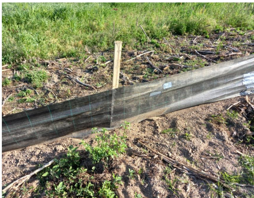
Obr. 4 - detail svodné textilie formou „silt-fence“ (vlastní foto 5/2023)
