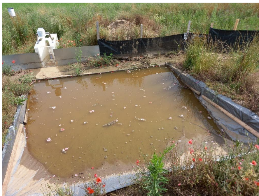
Obr. 33– sedimentační jímka č. 2 před vyčištěním (vlastní foto 7/2023)
