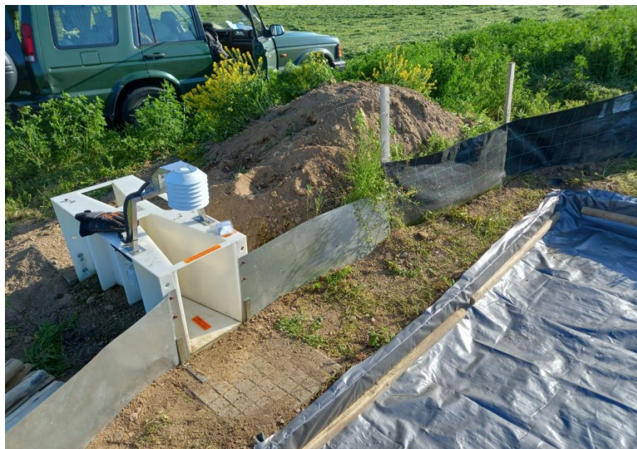
Obr. 7 – detail umístění svodné textilie u jímky (vlastní foto 5/2023)
