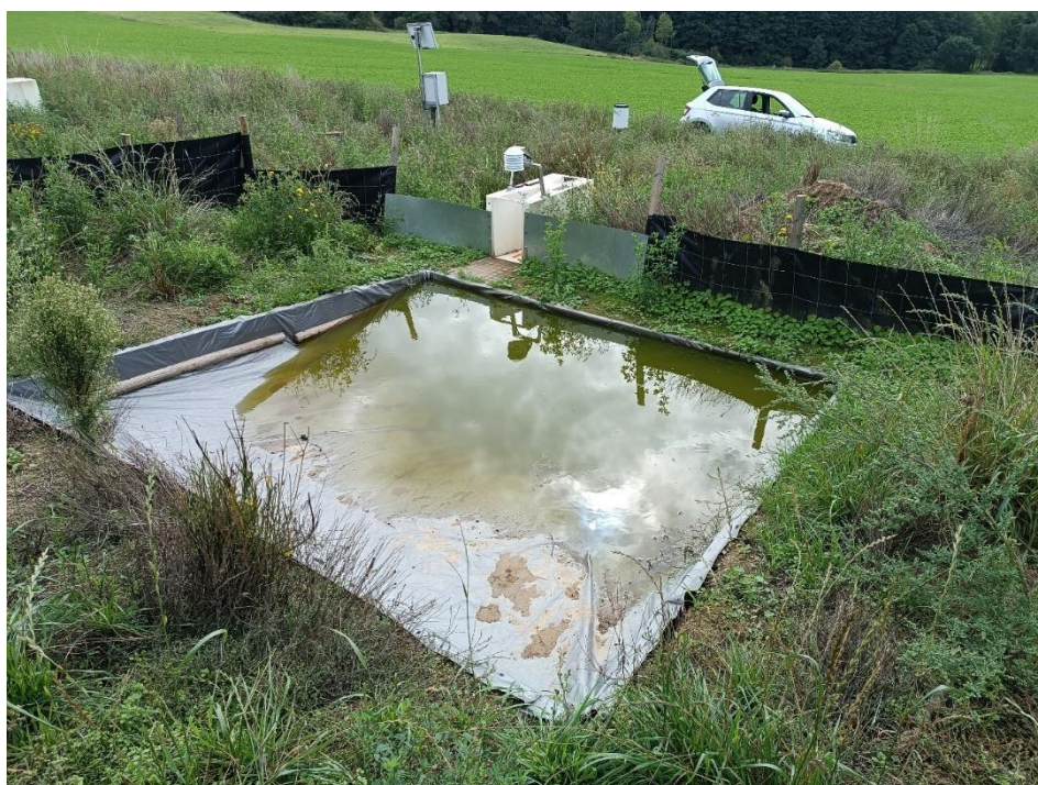
Obr. 38 - jímka č. 2 před vyčištěním (vlastní foto 9/2023)
