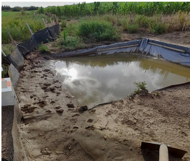
Obr. 34 – sedimentační jímka č. 1 před vyčištěním (vlastní foto 7/2023)
