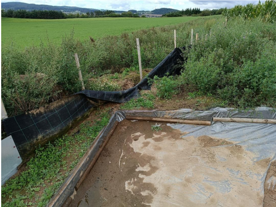
Obr. 40 - poničená svodná textilie (vlastní foto 9/2023)
