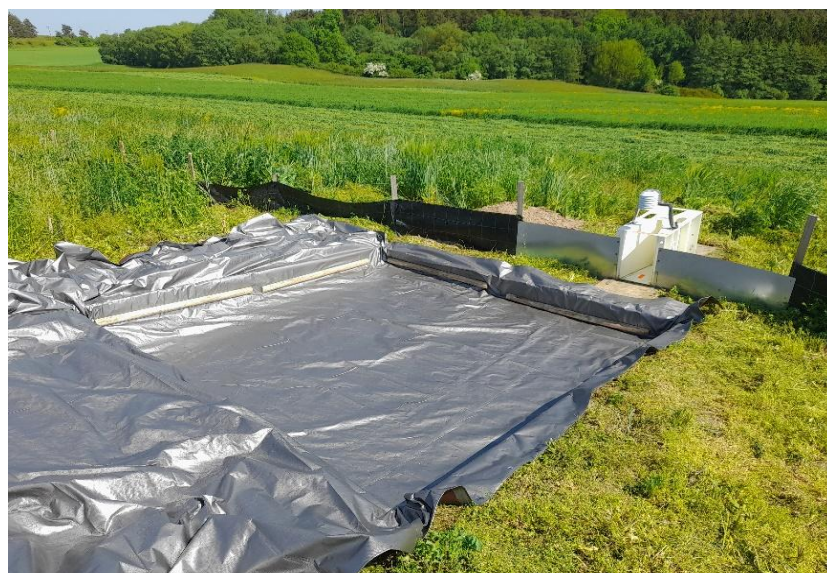
Obr. 12 - úprava textilie jímky (vlastní foto, 5/2023)
