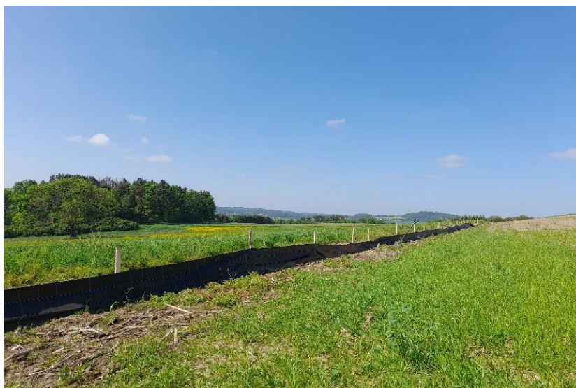
Obr. 14 - opravovaná svodná textilie (forma silt-fence, vlastní foto 5/2023)
