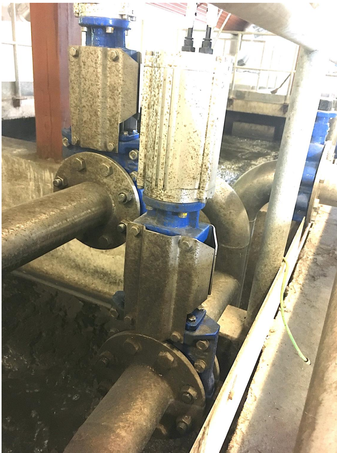
PŘÍLOHA Č. 3 – pneumatický pohon umístěný na nožovém šoupěti (ČOV Obříství)
