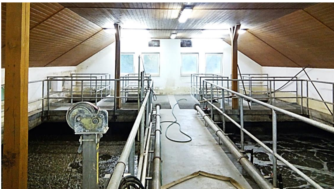
Obrázek 8 - Část vnitřních prostor ČOV Obrůstvi po rekonstrukci
