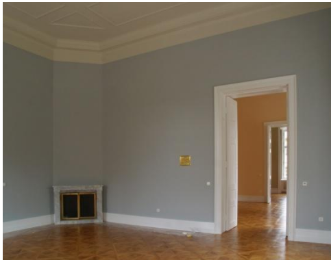
Obrázek 9 - Topení, malá zlatá dvířka na stěně
