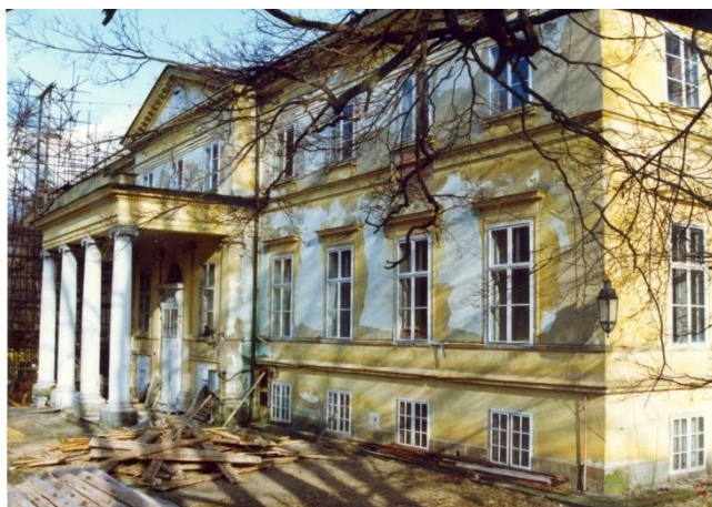
Obrázek 5 - Zámek před rekonstrukcí
