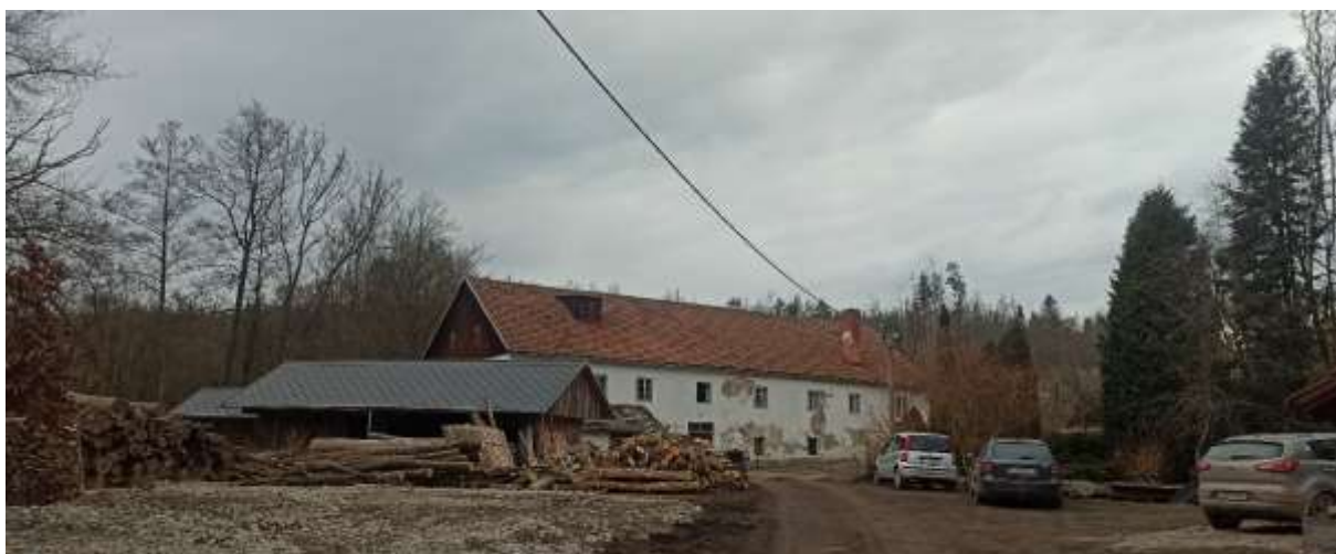
Budova bývalé pile (foto: Kristina Kotačková, 2021)
