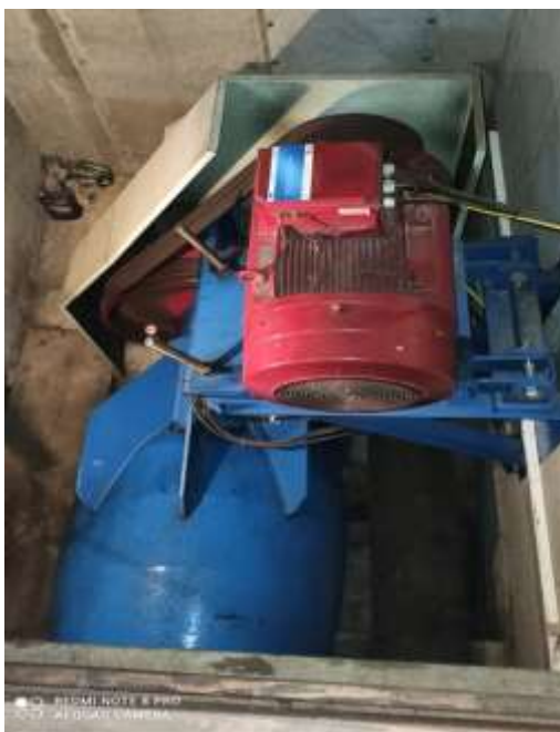
Obrázek 21 Kaplanova turbína na výrobě elektřiny (Kotačková, 2021)
