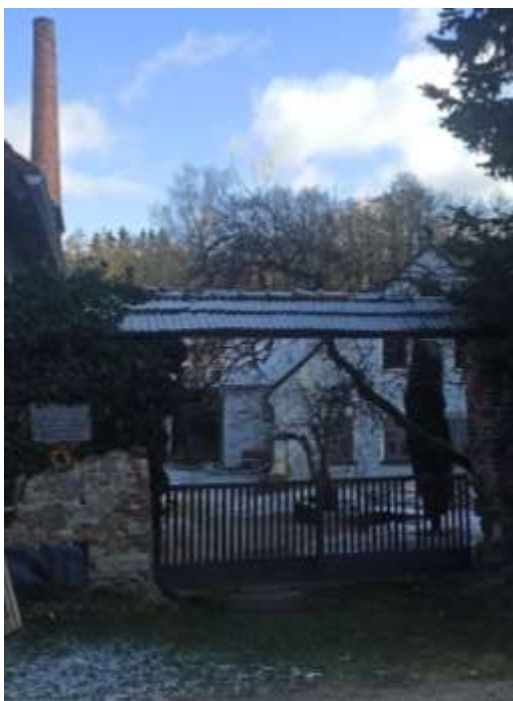
Obrázek 13 Zrekonstruovaná část (Kotačková, 2021)
