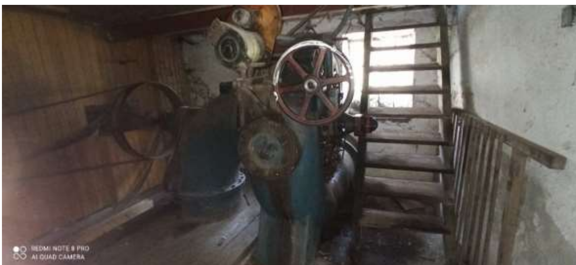
Francisova turbína na výrobu elektřiny (foto: Kristina Kotačková, 2020)
