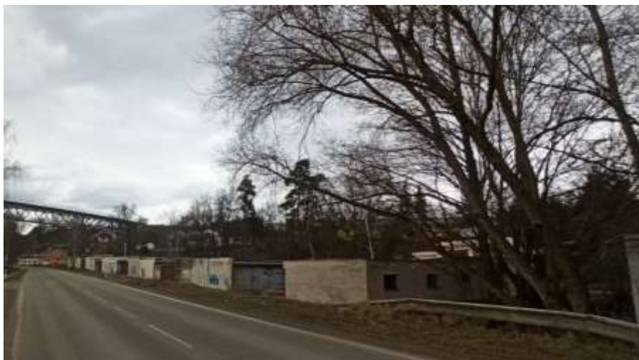
Obrázek 20 Vystavěné garáže na původním místě mlýna (Kotačková, 2021)
