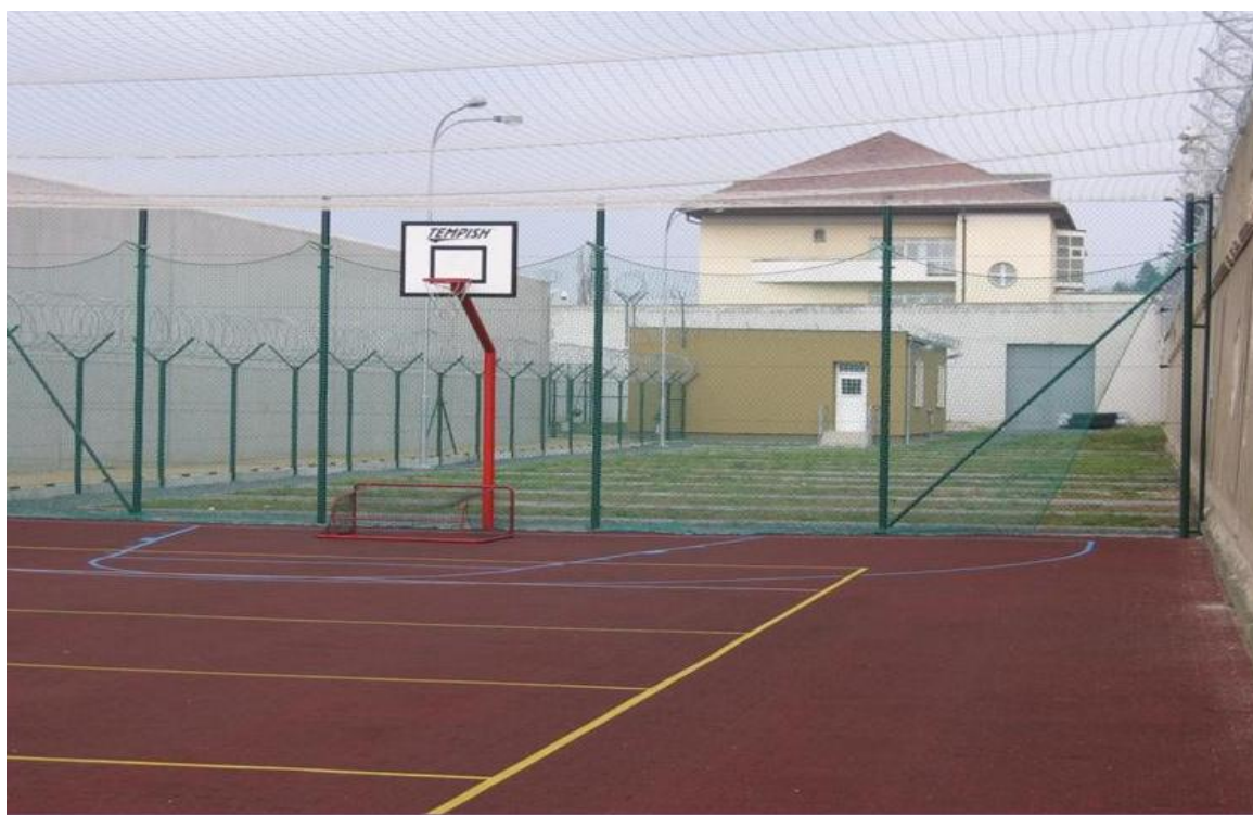
Obr. 17 Sportovní areál pro chovance ÚpVZD Brno
