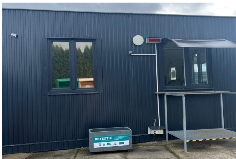
Obrázek 15 – Modulový dům sloužící jako zázemí pro pracovníky na sběrném dvoře
