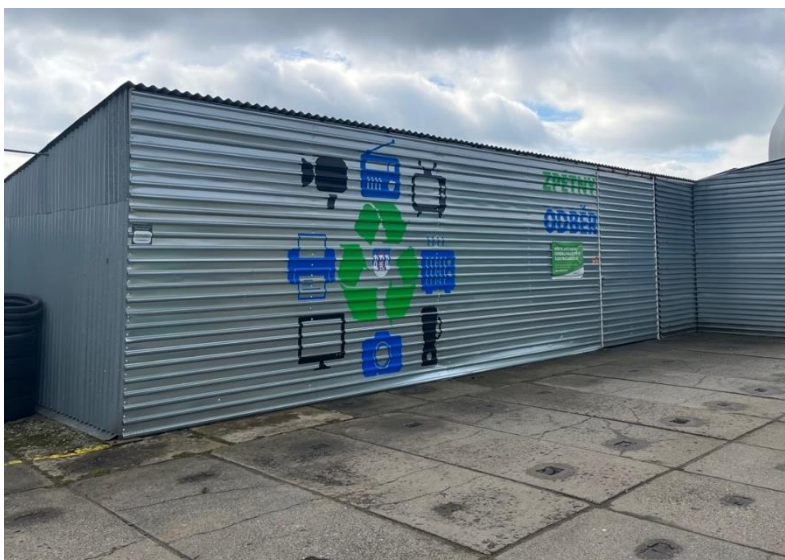
Obrázek 13 – Přístřešek sloužící k odevzdávání elektroodpadu pro zpětný odběr
