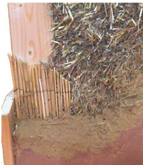
Obr. č. 15: Detail izolace ze slaměných balíků „Mokrý německý způsob“ (vlastní zdroj, 2012)
