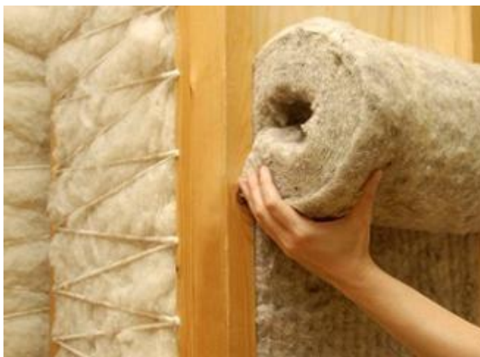
Obr. č. 31: Aplikace izolace z ovčí vlny (Wronová, 2010)
