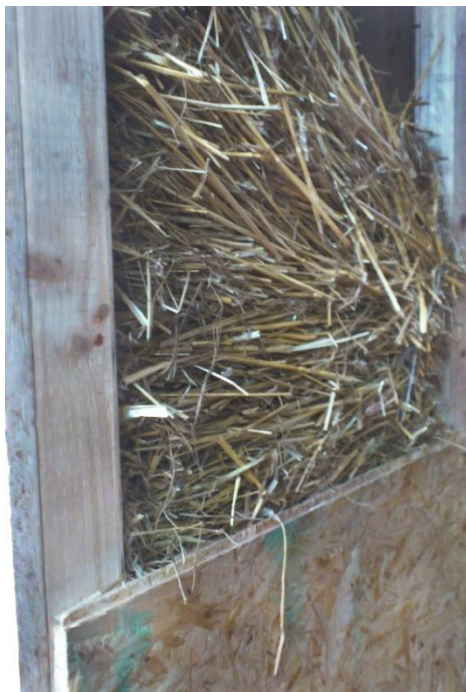
Obr. č. 14: Detail izolace ze slaměných balíků „Suchý rakouský způsob“ (vlastní zdroj, 2012)
