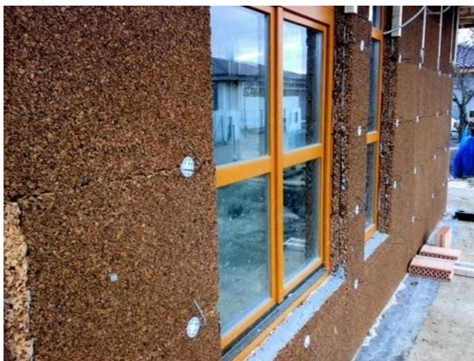
Obr. č. 34: Stěna izolovaná korkovými deskami (Korek-jelinek, 2004)
