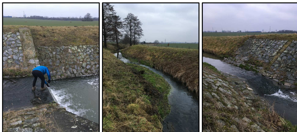
Obr. 29 Leskava – charakter úseku 2 [Čihák,2021]
