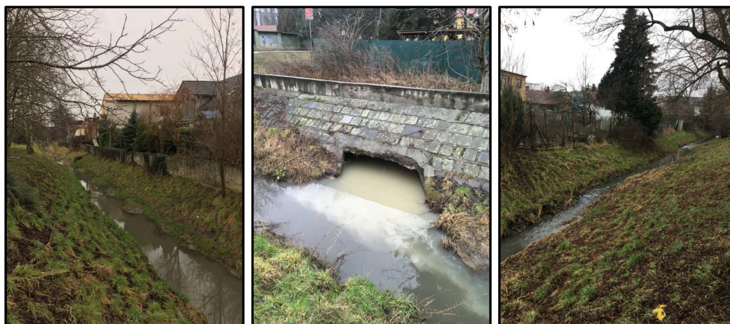
Obr. 34 Leskava – charakter úseku 7 [Čihák,2021]
