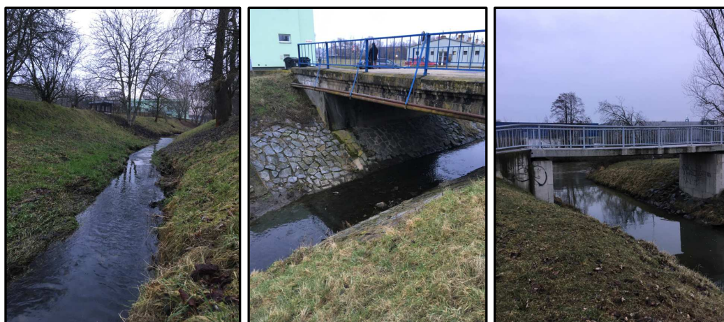
Obr. 28 Leskava – charakter úseku 1 [Čihák, 2021]
