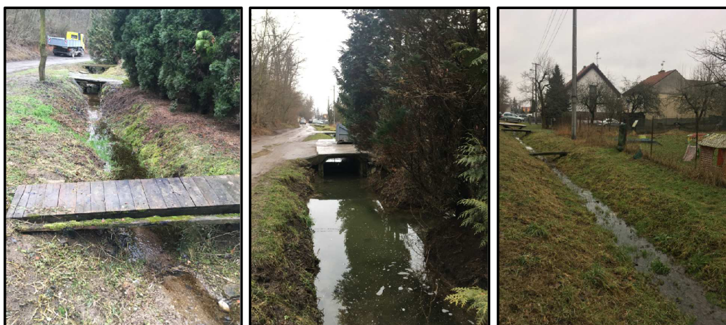
Obr. 38 Leskava – charakter úseku 12 [Čihák,2021]
