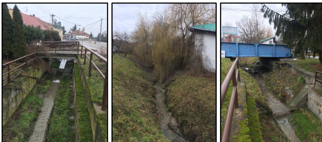
Obr. 37 Leskava – charakter úseku 10 [Čihák,2021]
