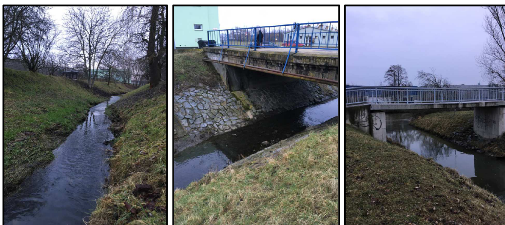
Obr. 28 Leskava – charakter úseku 1 [Čihák, 2021]
