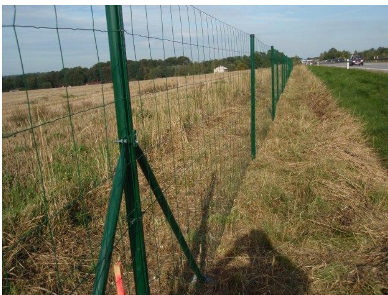
Obr. č. 17: Oplocení rychlostní komunikace R48 v úseku Frýdek-Místek – Český Těšín ( www.kavis.cz ).
