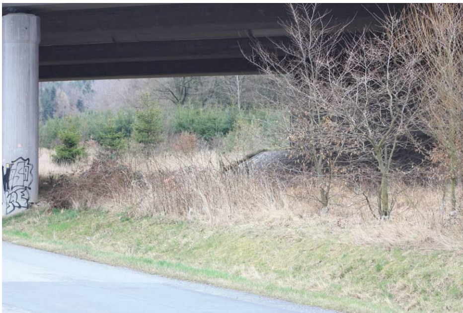
Obr.č.50: Fotografie dálničního mostu D5 Letkov, pohled od obce Letkov (vlastní).
