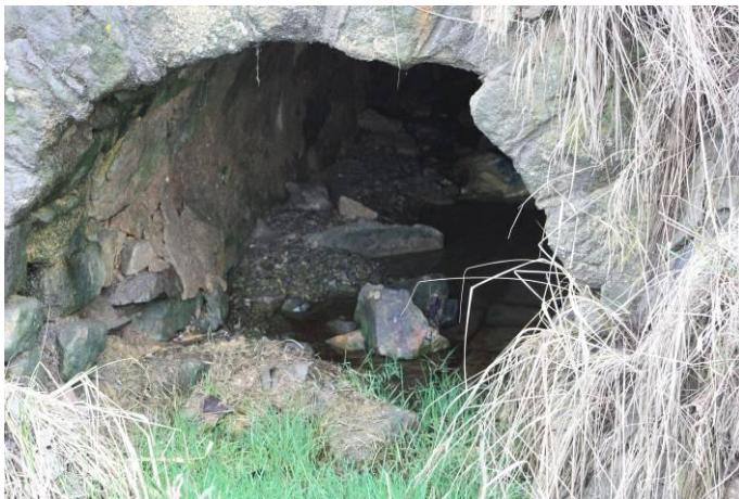
Obr.č.36: Fotografie propusti v prostoru křižovatky (vlastní).
