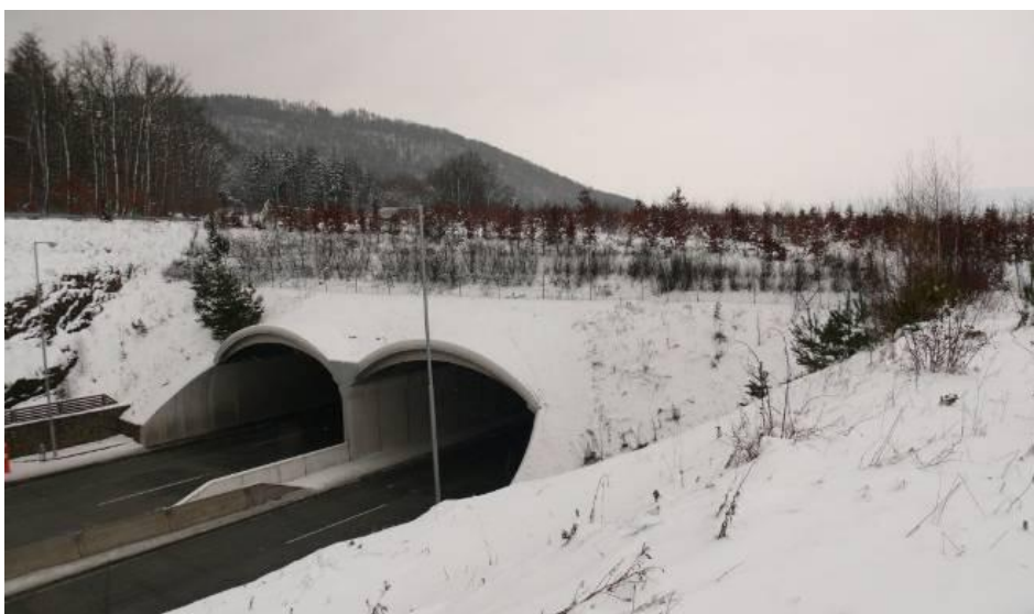
Obr. č. 15: Ekodukt Dolní újezd, R35 (ceskedalnice.cz).
