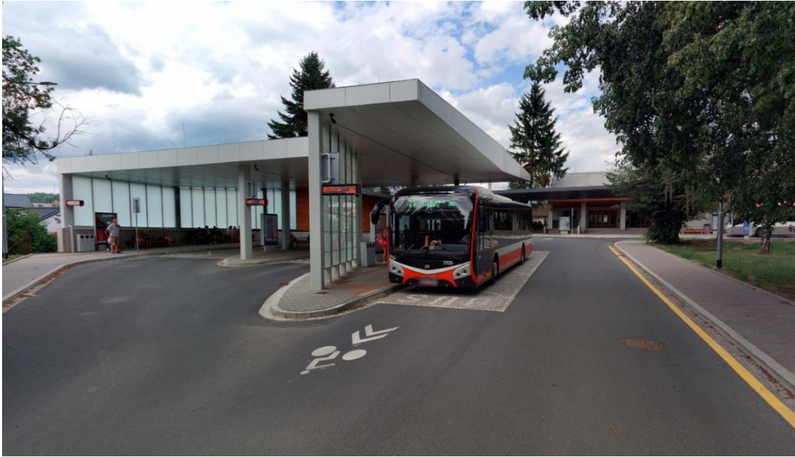
Obrázek 5 Nástupiště a zastřešení terminálu
