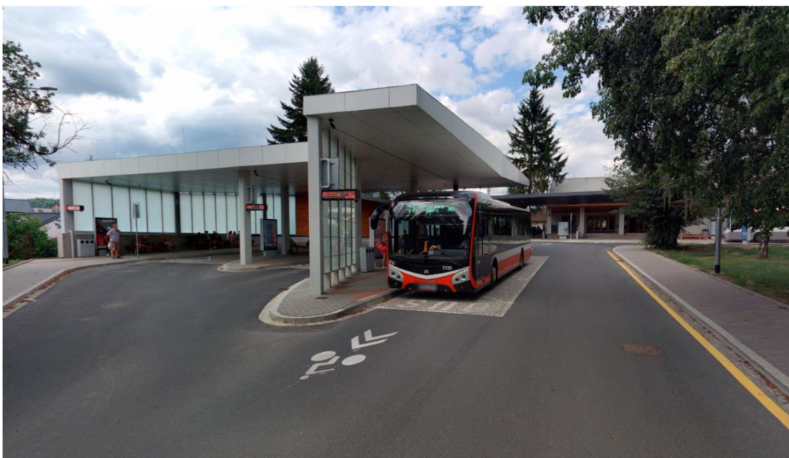
Obrázek 5 Nástupiště a zastřešení terminálu
