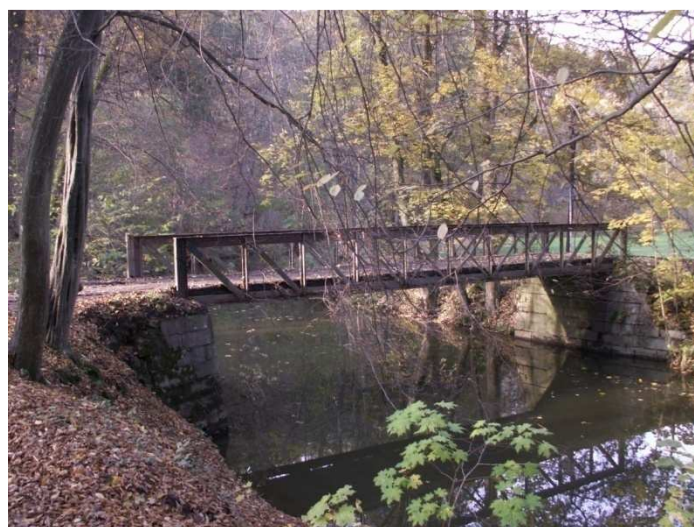
Obr. č. 12: Železný most; (zdroj: vlastní foto)
