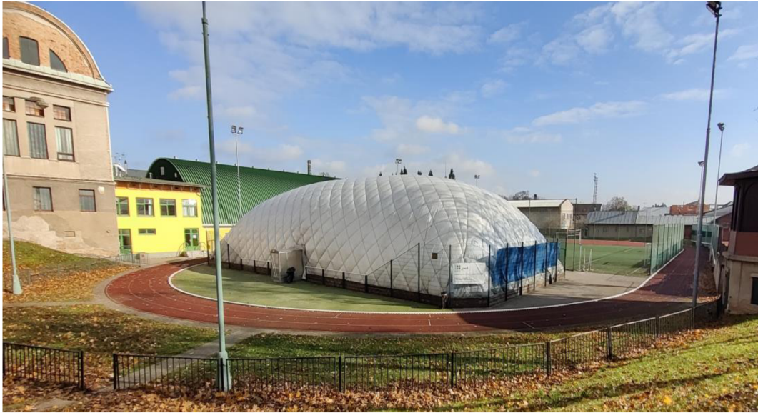
Fotografie 5: Přetlaková hala na tenis
