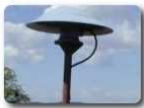
Obr. č. 7.: Elektrická rotační siréna (40)
