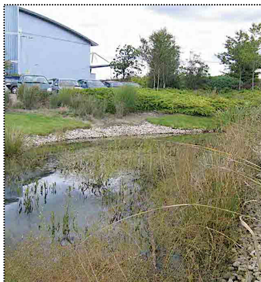
Příloha 5: Obr. 2: Retenční nádrž se stálým nadrženi v Londýně (zdroj: Woods-Ballard, 2015)
