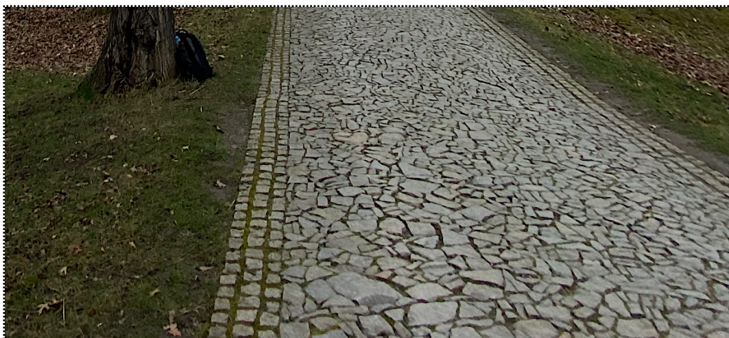
Příloha 3: Obr. 1: Polopropustná žulová dlažba v parku Stromovka v Praze (zdroj: Autor, 2024)
