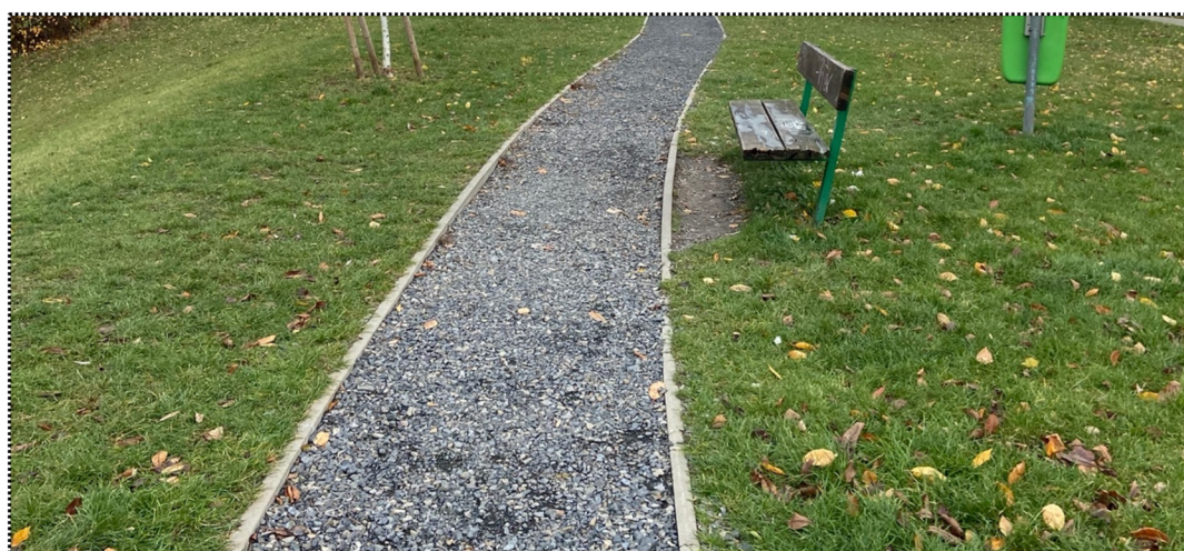
Příloha 3: Obr. 3: Propustná štěrková cesta u Retenční nádrže ul. U Járku v Hloubětíně, Praha (zdroj: Autor, 2024)
