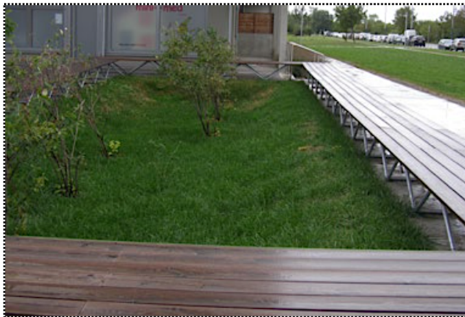
Příloha 4: Obr. 1: Zatravněný vsakovací průleh u hlavního nádraží ve Vídni, Rakousko (zdroj: Sýkorová et al., 2021)
