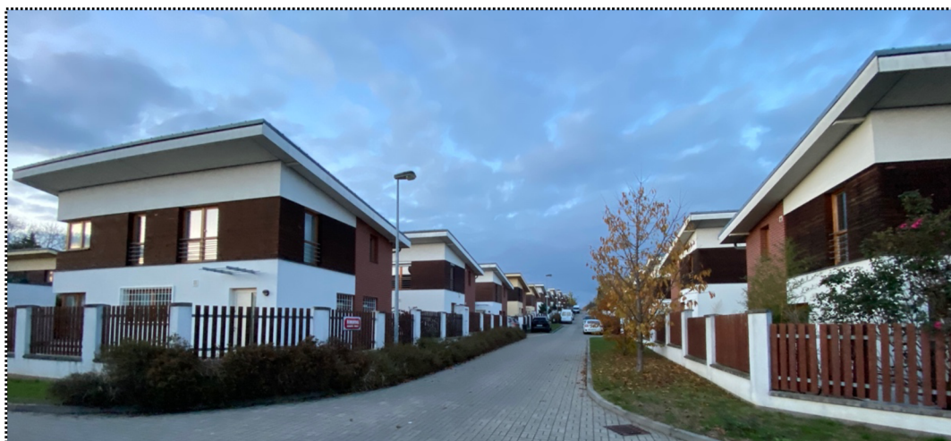
Příloha 7: Obr. 1: Pohled na lokalitu z křižení ulic Nad Hutěmi a Řimovská (zdroj: Autor, 2023)
