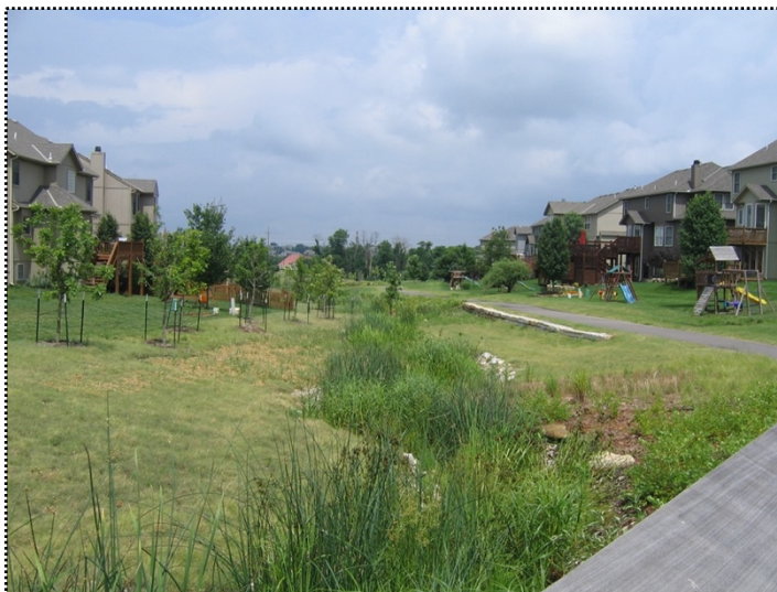
Obr. 10: Pohled na vytvořenou RZ v suburbánní lokalitě ve městě Lenexa v USA, která byla realizována v rámci programu „Rain to Recreation“. Středem RZ je vedena svodná rýha, osázena okrasnou vlhkomilnou vegetací, doplněna propustnou cestou pro pěší. Dále je RZ doplněna o rekreační a estetické prvky. (zdroj: Richards et al., 2009)
