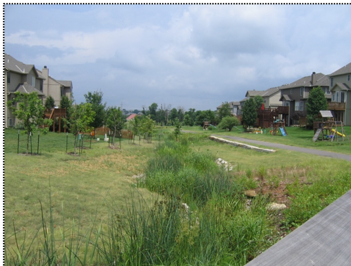
Obr. 10: Pohled na vytvořenou RZ v suburbánní lokalitě ve městě Lenexa v USA, která byla realizována v rámci programu „Rain to Recreation“. Středem RZ je vedena svodná rýha, osázena okrasnou vlhkomilnou vegetací, doplněna propustnou cestou pro pěší. Dále je RZ doplněna o rekreační a estetické prvky. (zdroj: Richards et al., 2009)
