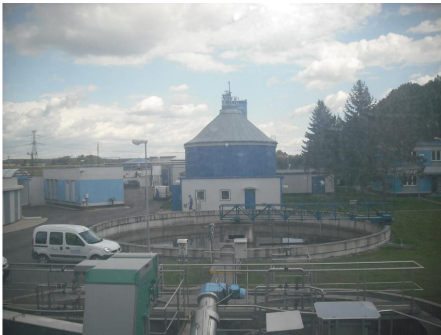
Obr. č. 3.3-19 ČOV Nový Jičín - vyhnivací a usazovací nádrž [zdroj: Čížová]
