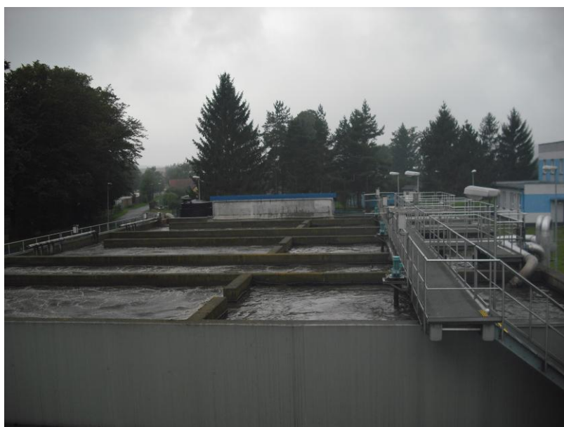
Obr. č. 3.3-16 ČOV Nový Jičín - kaskádová aktivační nádrž [zdroj: Čížová]
