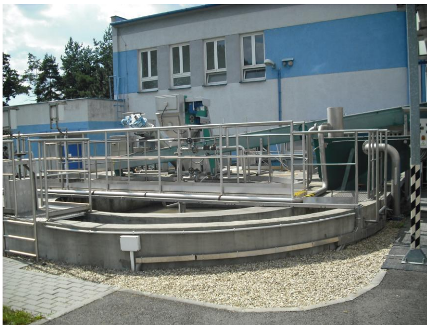
Obr. č. 3.3-14 ČOV Nový Jičín - lapák písku, strojně stírané česle [zdroj: Čížová]
