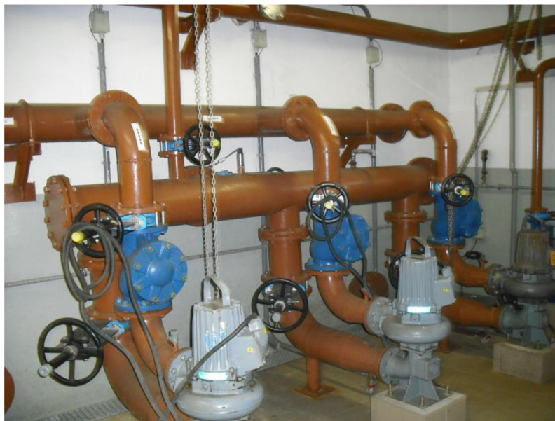
Obr. č. 3.3-17 ČOV Nový Jičín - čerpání vratného kalu [zdroj: Čížová]
