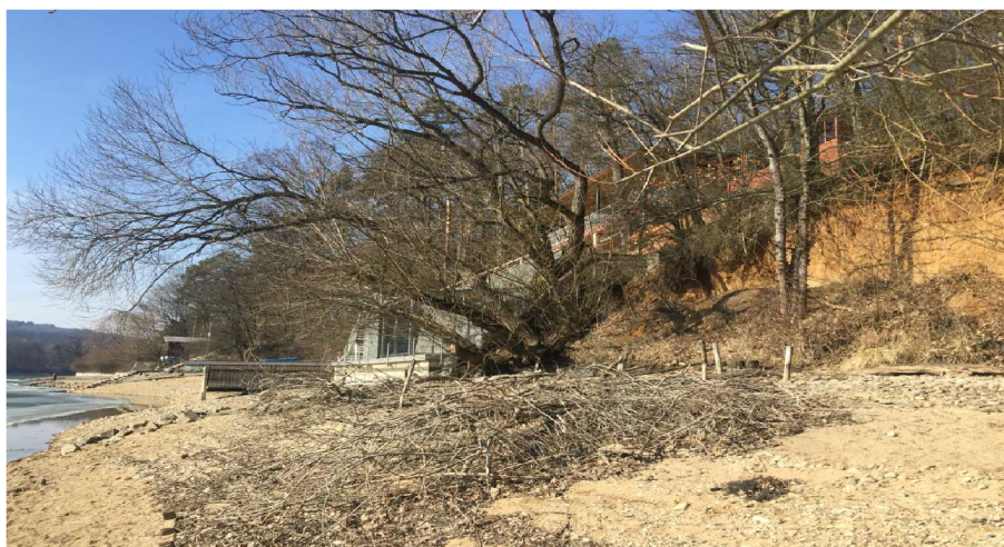
Obr. 5.2 Abrazní srub a stávající vegetace na břehu [foto: L. Skřížala, březen 2018]
