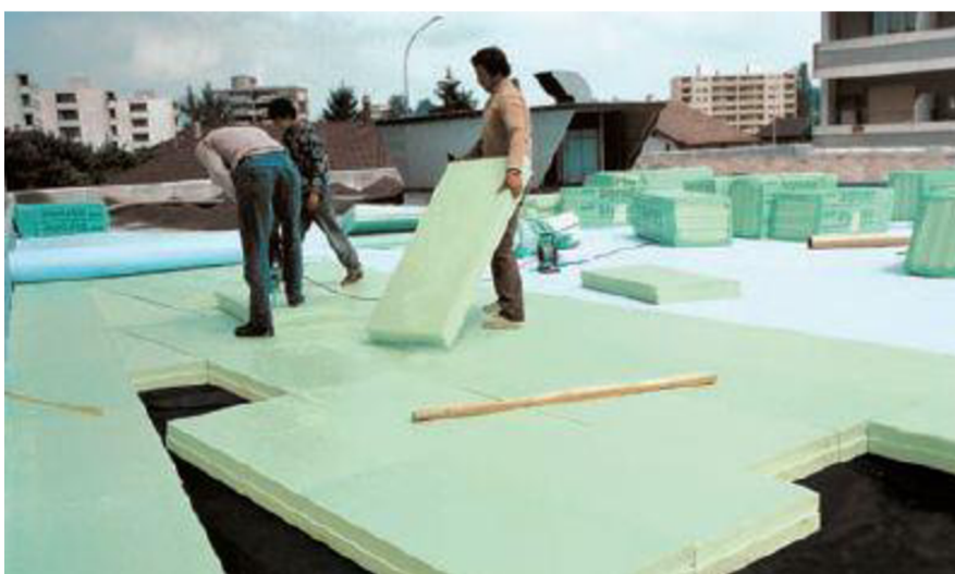
Obr. 1.3 Izolace z extrudovaného polystyrenu [15]
