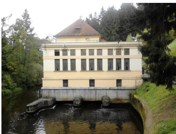
Obrázek č. 12: Vodní elektrárna Sedlice
