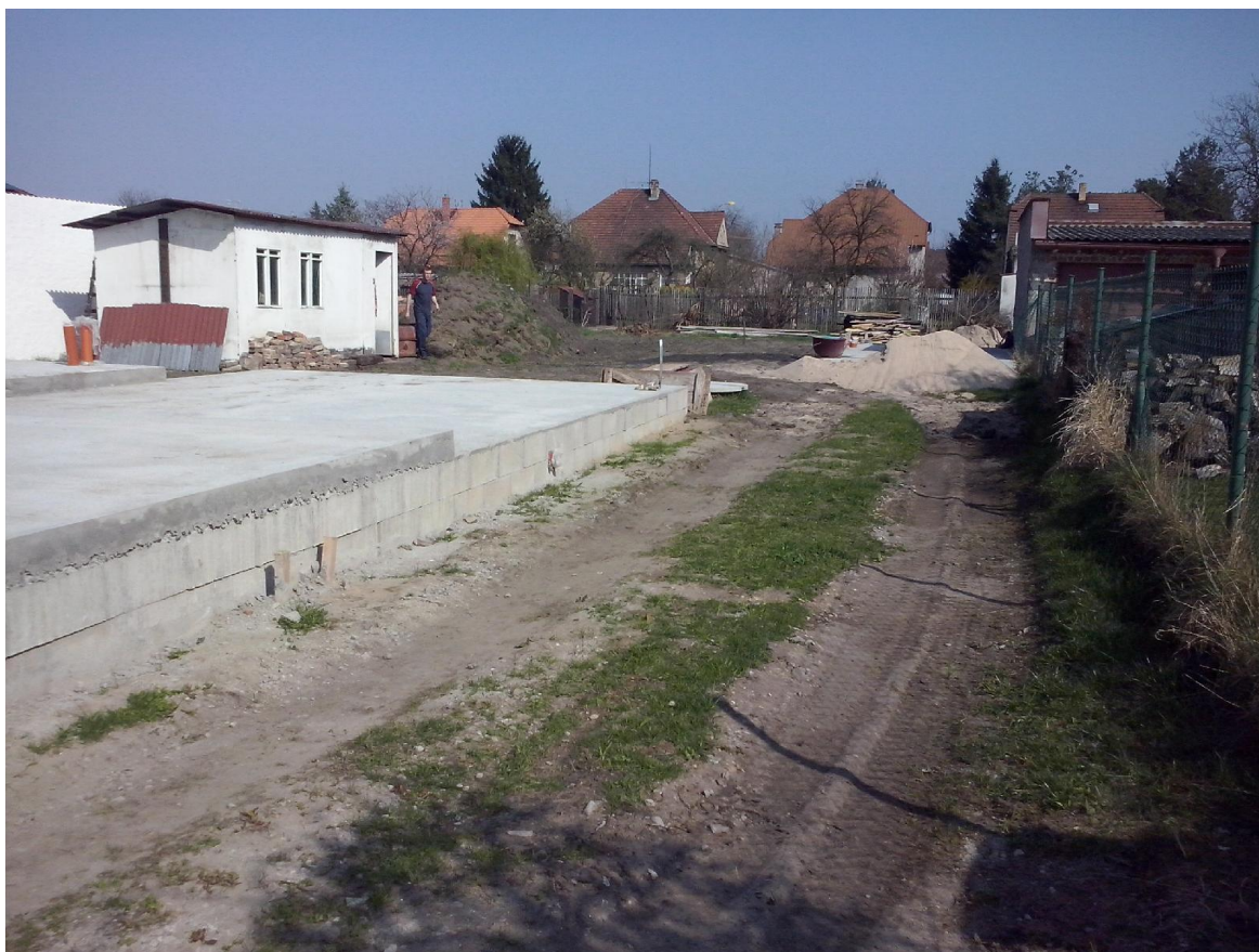
Obr. 6 stavební parcela, (vlastní zdroj)
