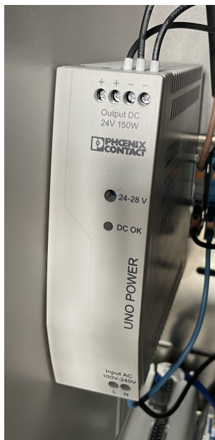
Obrázek 2.3: Napájecí zdroj pro stejnosměrných 24 V
