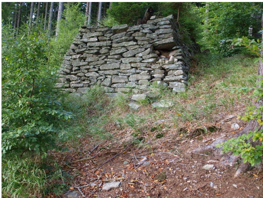
Obr. 3 Kamenná rovnanina na vrcholu III. svážnice. (Zdroj: P.Němec, 2019)
