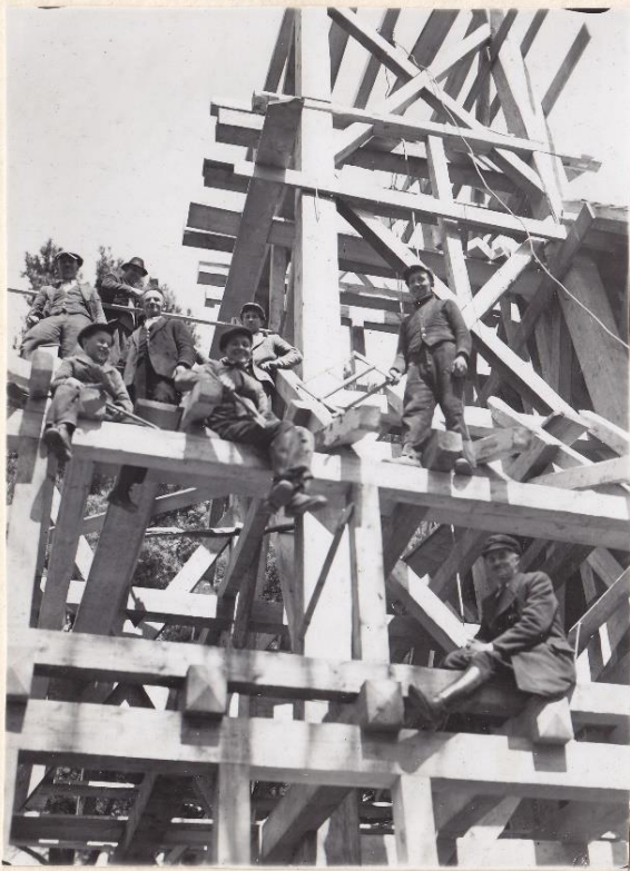
Obrázek č. 11: Tesařský Mistr Michal Fabián spolu se svými spolupracovníky, dělající na kostele svatě Anny z Větrkovic. Sestava konstrukce věže.
