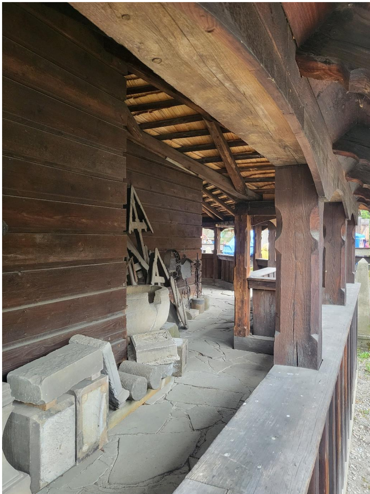
Obrázek č. 13: Krytý přístřešek dnes sloužící jako odkladiště.
