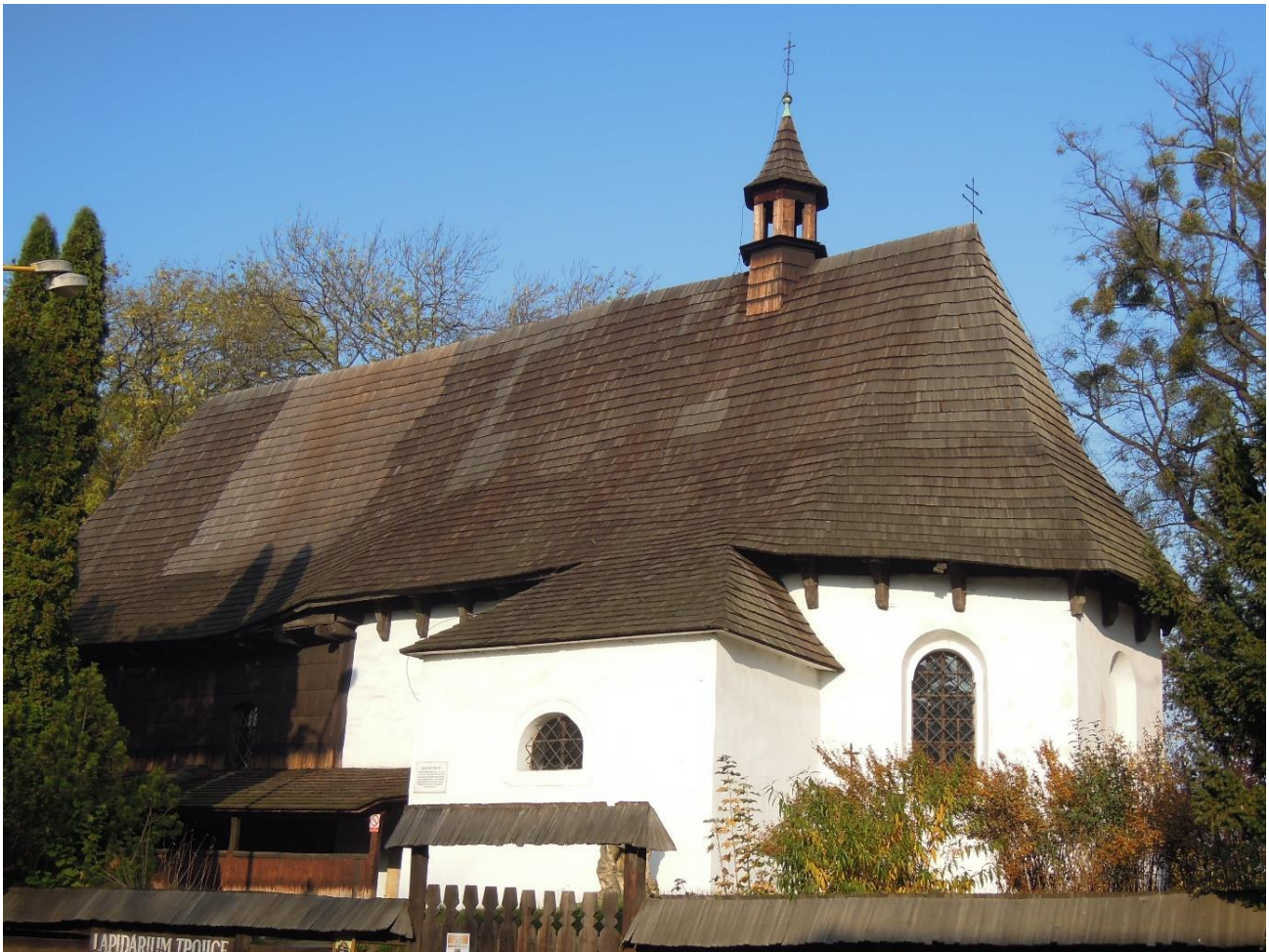
Obrázek č. 4: Kostel ve Valašském Meziříčí.
