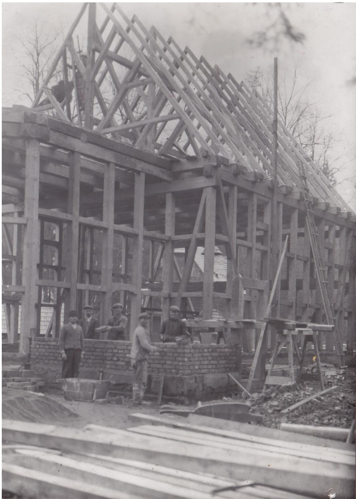
Obrázek č. 33: Práce na zděné sakristii.
