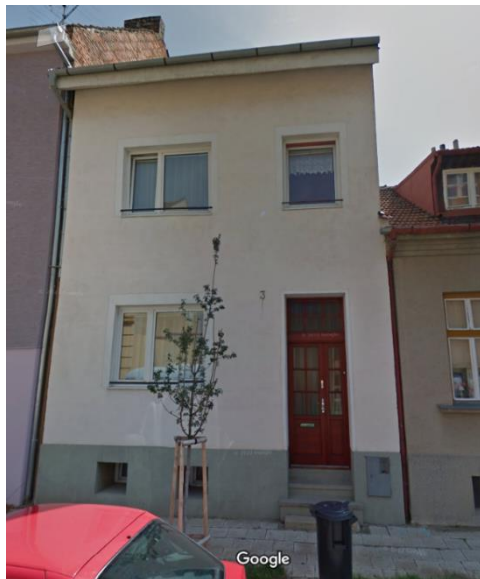
Obr. č. 9 - Pohled na vybranou nemovitosti [29]
