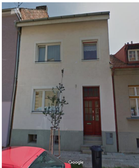
Obr. č. 9 - Pohled na vybranou nemovitosti [29]
