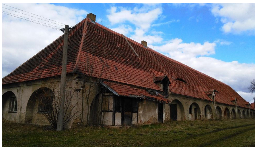
Obr. 122 Historická budova navržena k rekonstrukci (Zdroj: vlastní fotografie, 2019)
