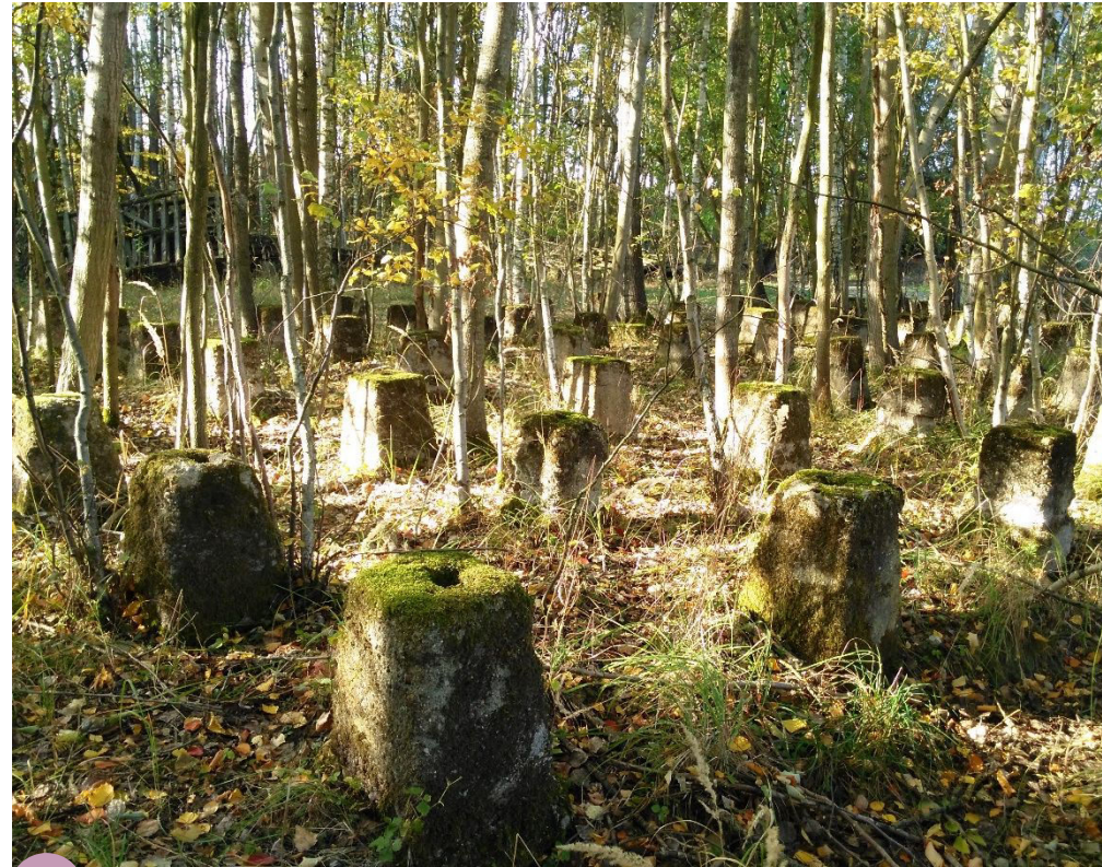
Obr. 98 Betonové patky bývalé sušárny v rozpadající se cihelně u Kublova (Zdroj: vlastní fotografie, 2018)
