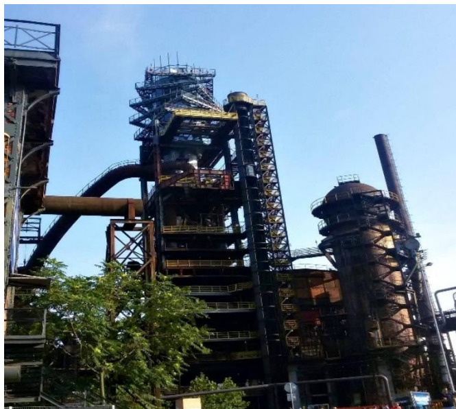
Obrázek 11: Vysoká pec č. 1 po revitalizaci (Bolt Tower)
