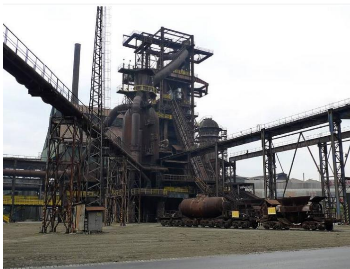
Obrázek 9: Vysoká pec č. 1 před revitalizací
