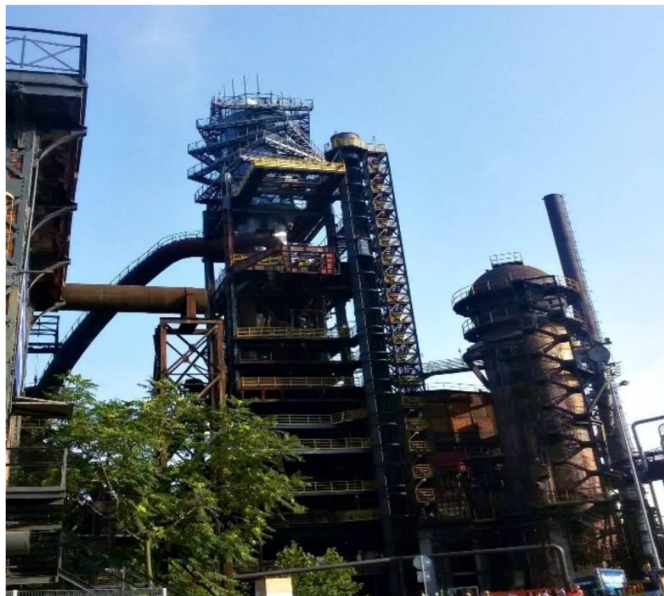
Obrázek 11: Vysoká pec č. 1 po revitalizaci (Bolt Tower)
