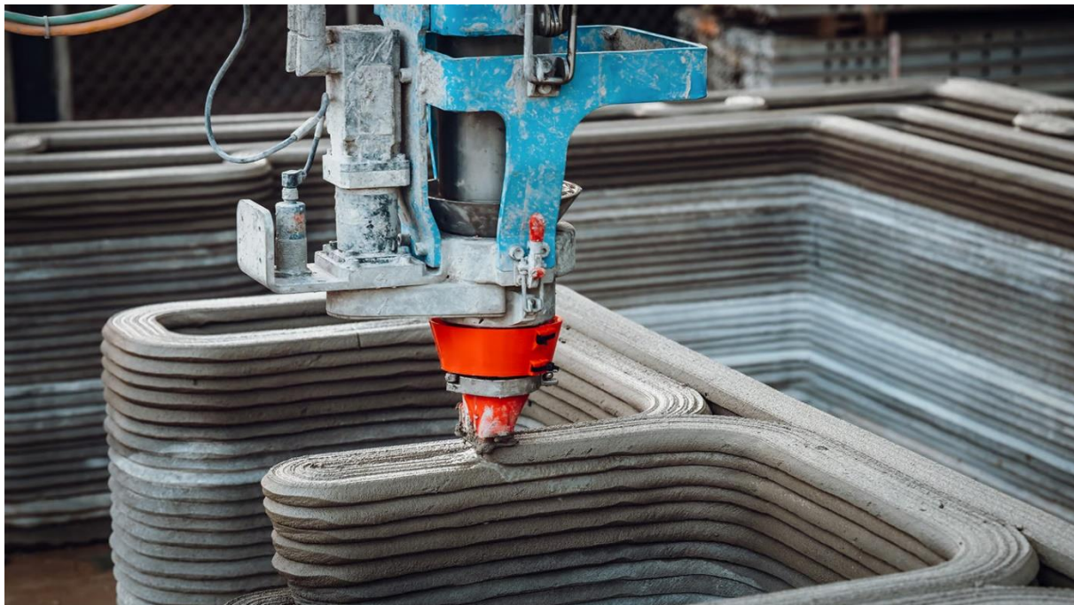
Obrázek 13 Tiskárna tisknoucí dům (Schwaar, 2024)
