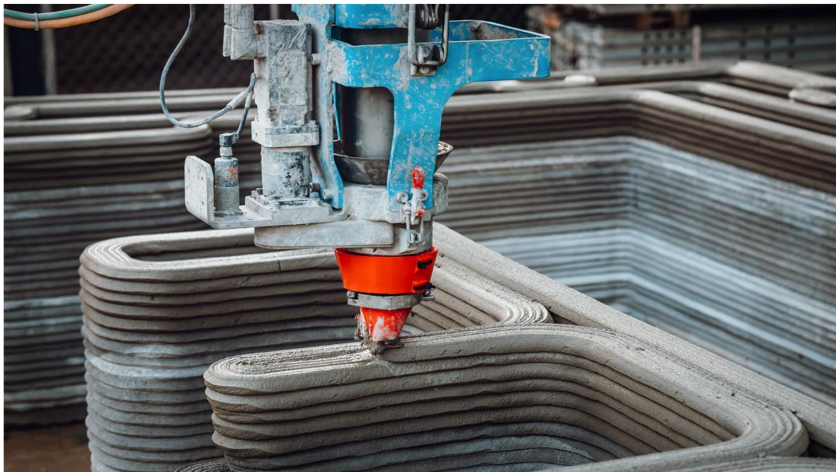
Obrázek 13 Tiskárna tisknoucí dům (Schwaar, 2024)
