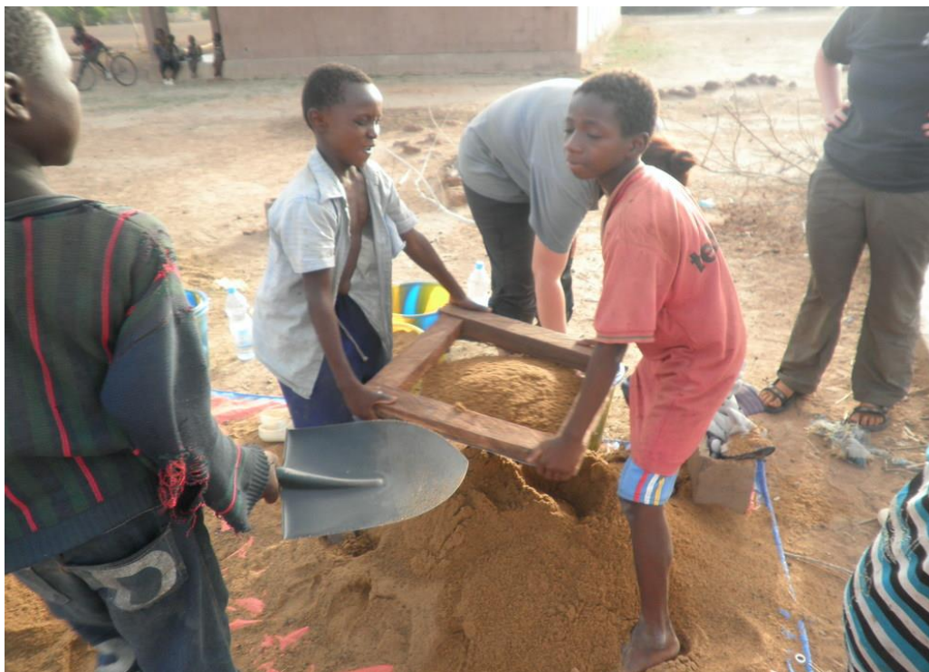
Obr. 7 Přípravy pro vybudování filtrační studny (zdroj: ohorizons.org)
