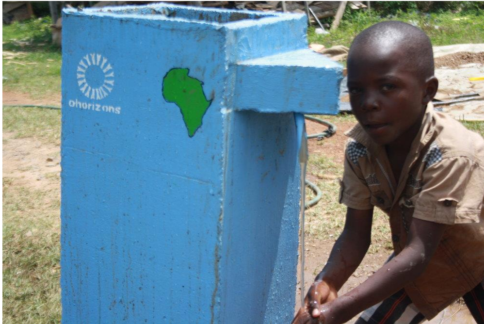
Obr. 6 Filtrační studna v Keni (zdroj: ohorizons.org)
