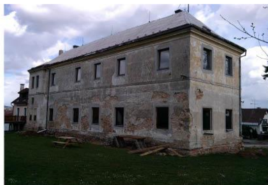
Příloha č. 11: Zbytky jezuitského dvora (Foto: Zuzana Kořínková)
