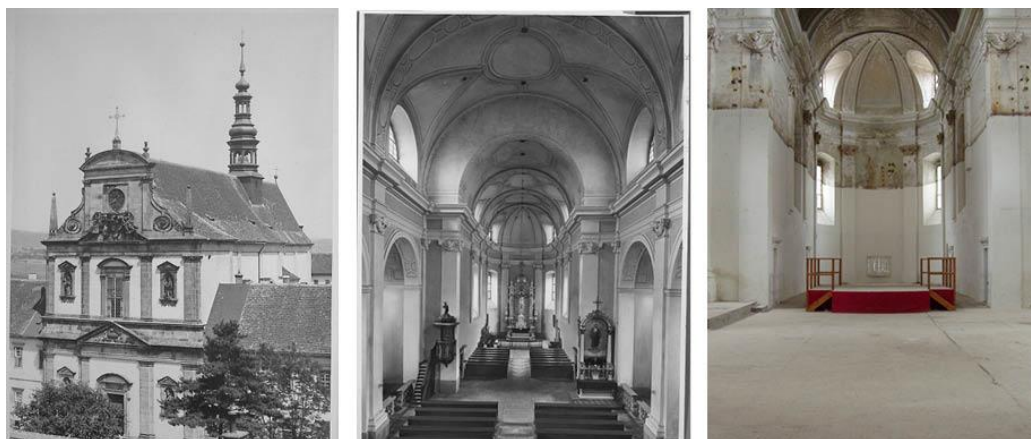
Obr. č. 9: Kostel sv. Josefa na historických fotografiích a současná podoba interiéru kostela (zdroj: archiv Věznice Valdice)
