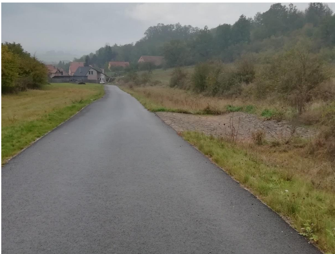
Cesta HC 2 – sjezd na pozemek, povrch bez známek poškození
