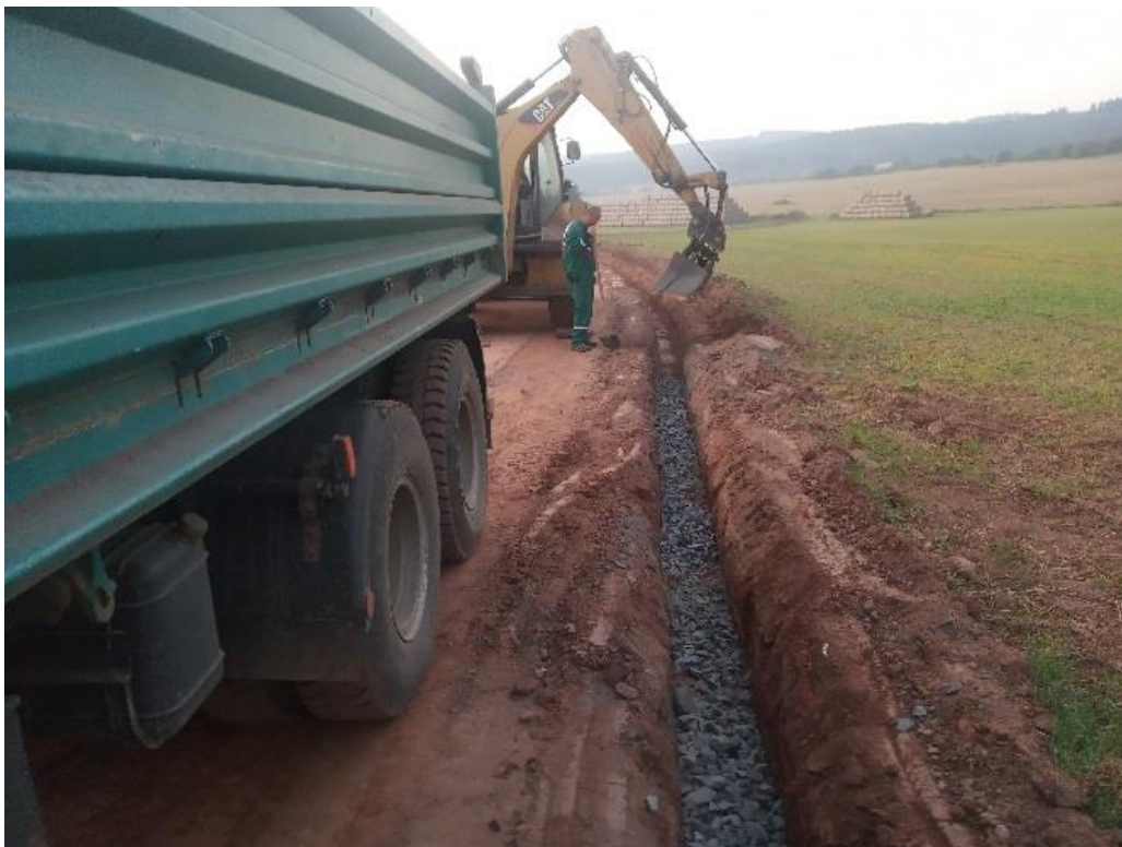
Cesta VPC 8 – realizace polní cesty, pokládání drenáže
