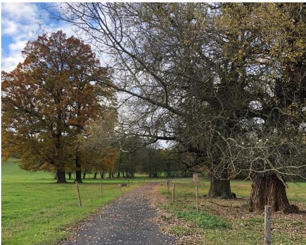
Cesta HC 5 – konstrukce povrchu bez známek poškození
