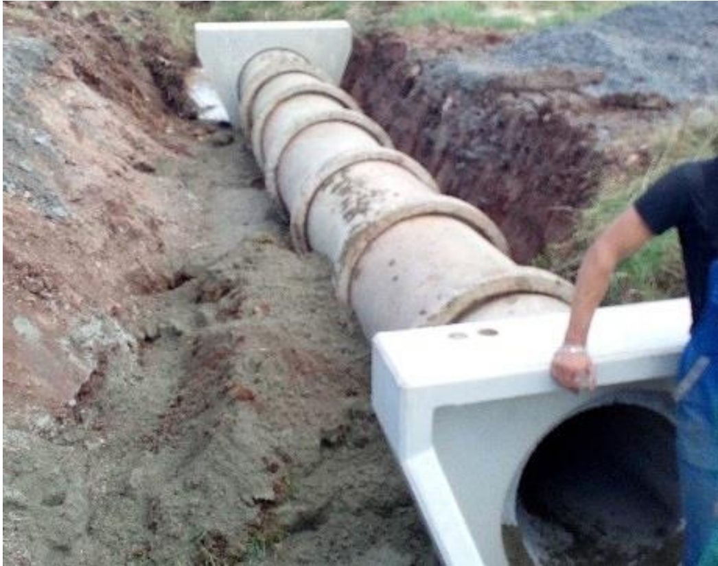
Cesta VPC 8 – budování propustku
