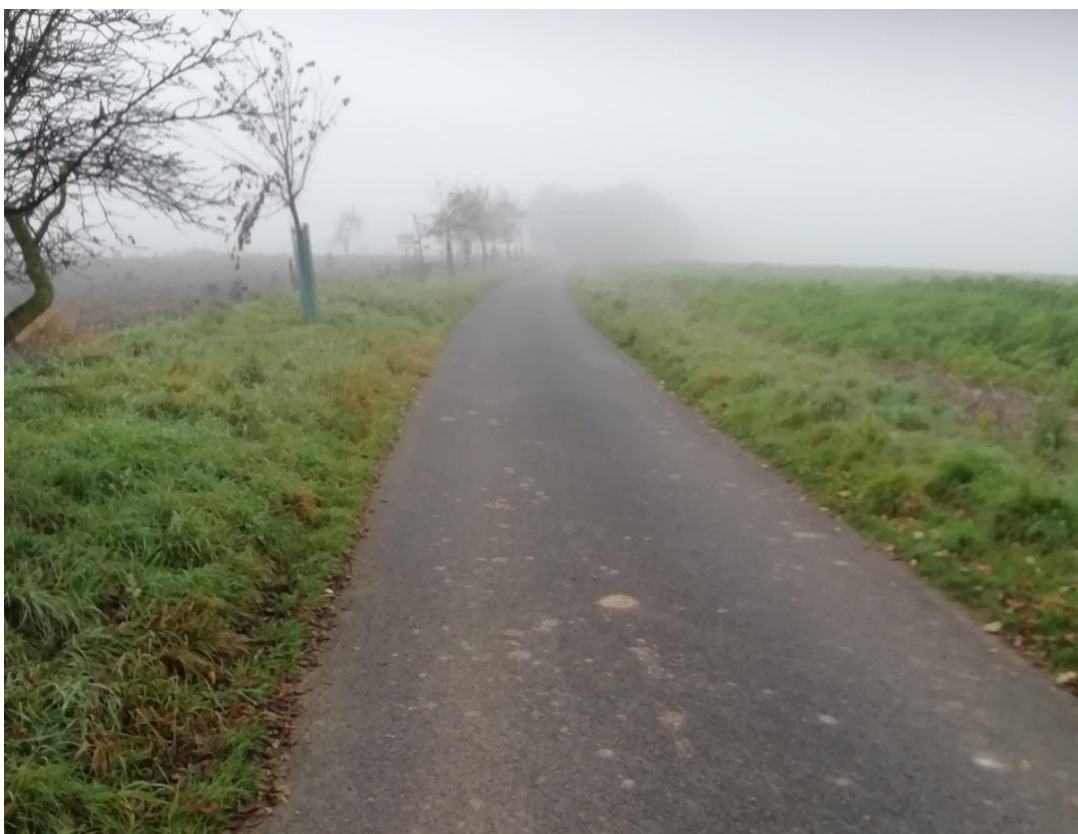
Cesta VC 17 – není patrné poškození povrchu
