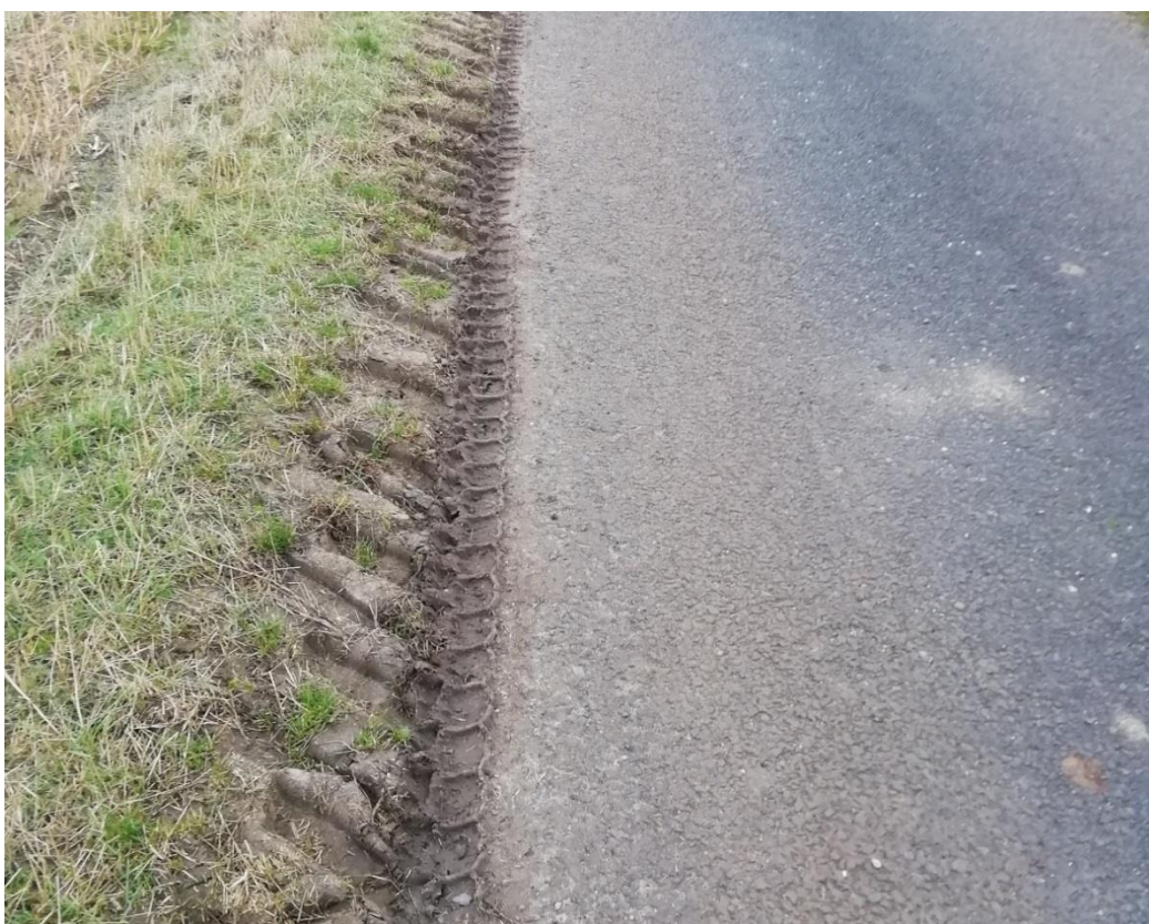
Cesta OC 12 – podkladní vrstvy stabilní, na krajích polní cesty zaznamenán pojezd zemědělské techniky
