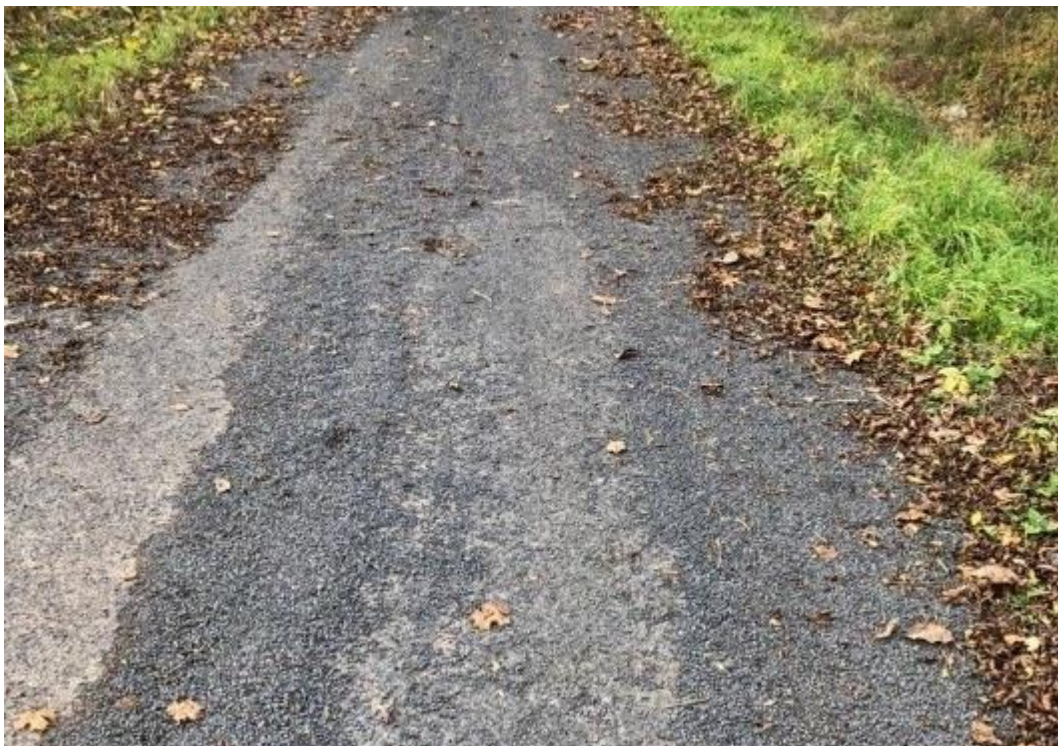
Cesta HC 5 – staničení cca km 0,800, povrch bez známek poškození
