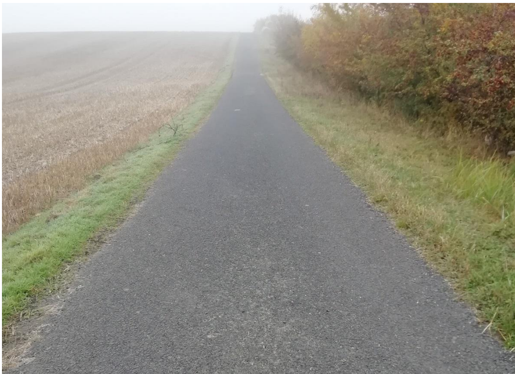
Cesta HC 1 – staničení km 0,800 – 1,100
