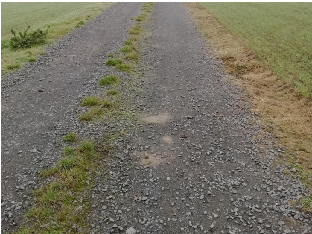
Cesta OC 14 – podkladní vrstvy stabilní, zatravnňovací vrstva již zarostlá trávou
