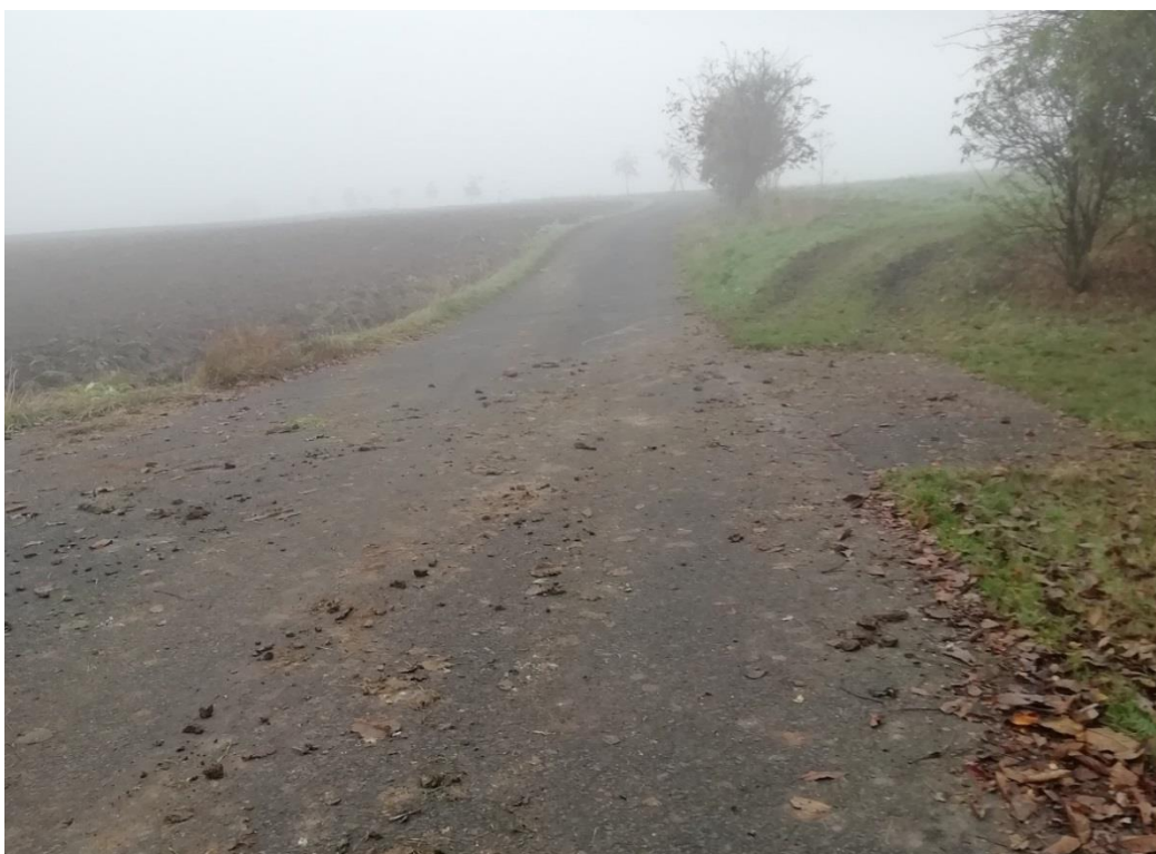
Cesta HC 1 – sjezd na pozemek
