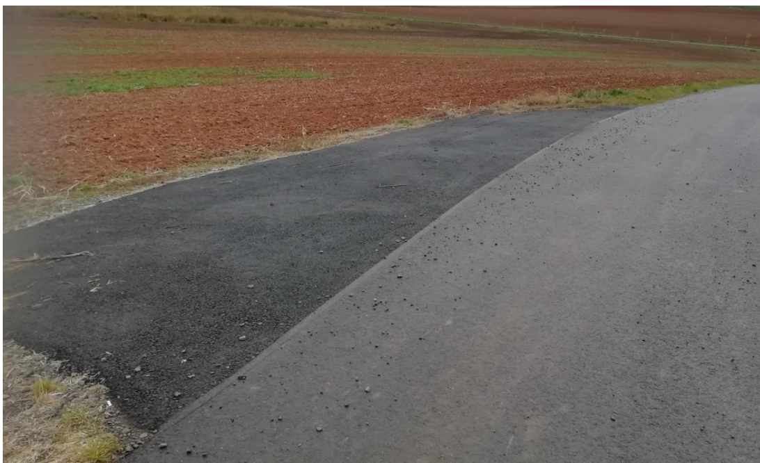
Cesta HC 1 – sjezd na pozemek, povrch bez známek poškození
