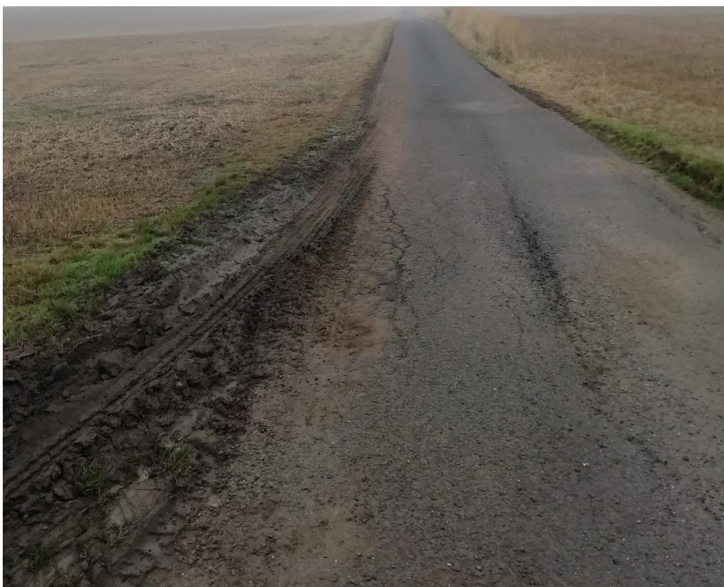
Cesta HC 1 – staničení km 0,000 – 0,800
