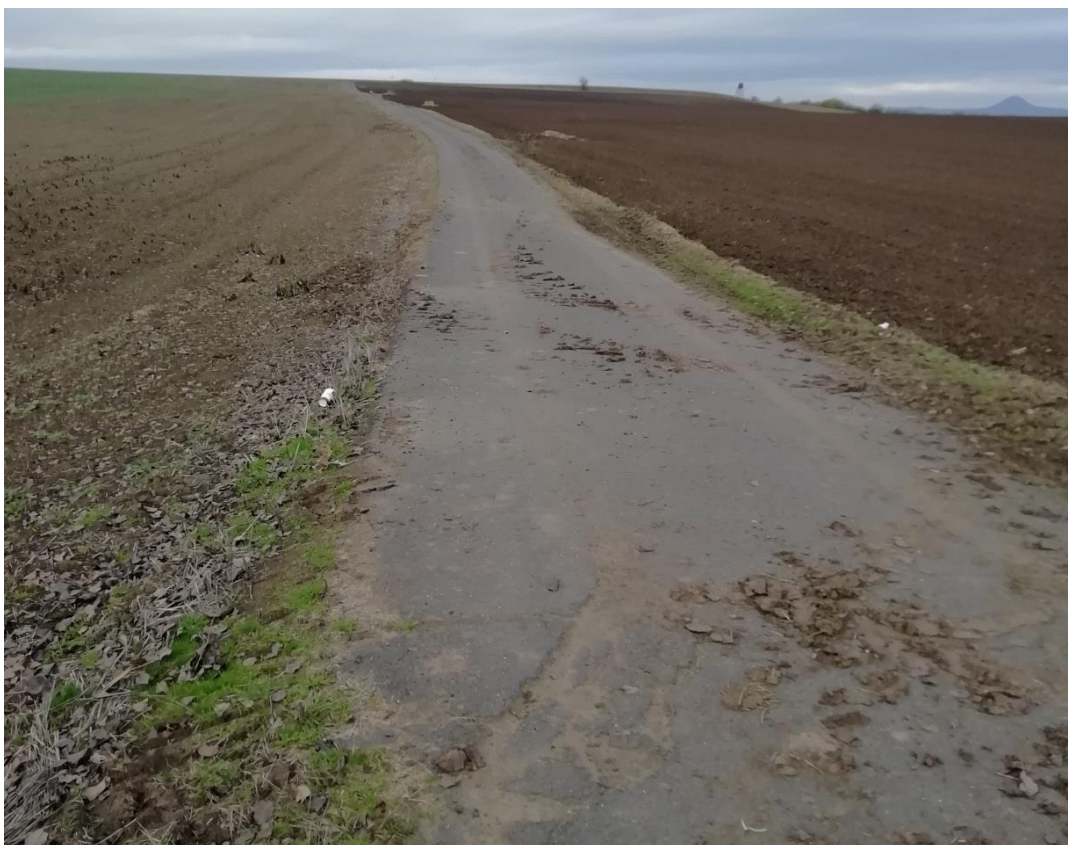
Cesta C 14 – podkladní vrstvy bez známek poškození, stabilní
