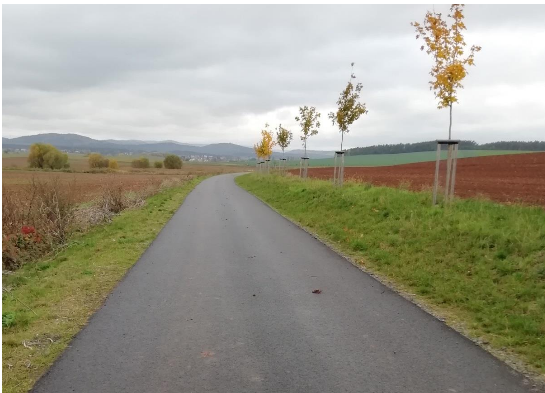
Cesta HC 1 – výsadba, povrch bez známek poškození
