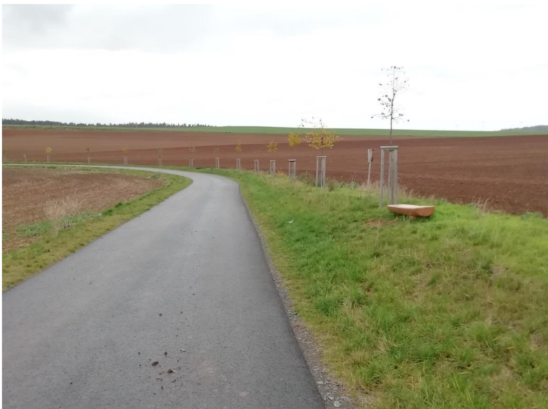
Cesta HC 1 – lavičky, povrch bez známek poškození
