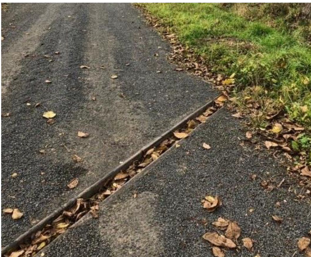
Cesta HC 5 - svodnice, odvodnění
