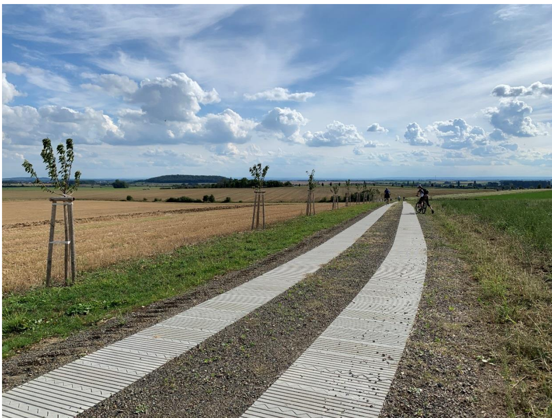
Kolejová polní cesta realizovaná SPÚ, Pobočkou Nymburk
