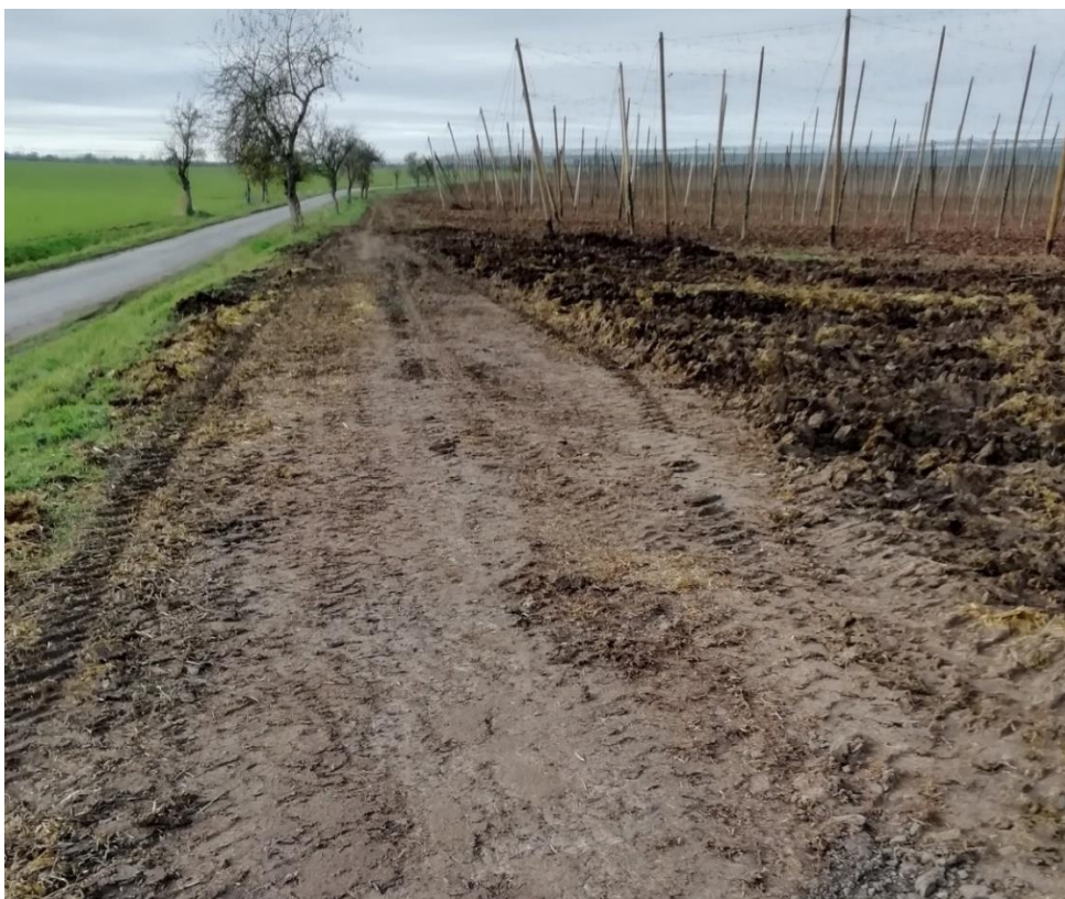
Cesta 2 – stav konstrukce vozovky – podkladní vrstvy stabilní
