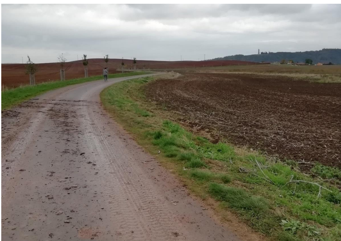
Cesta HC 1 – v blízkosti místa křížení s VTL plynovodem, povrch bez známek poškození
