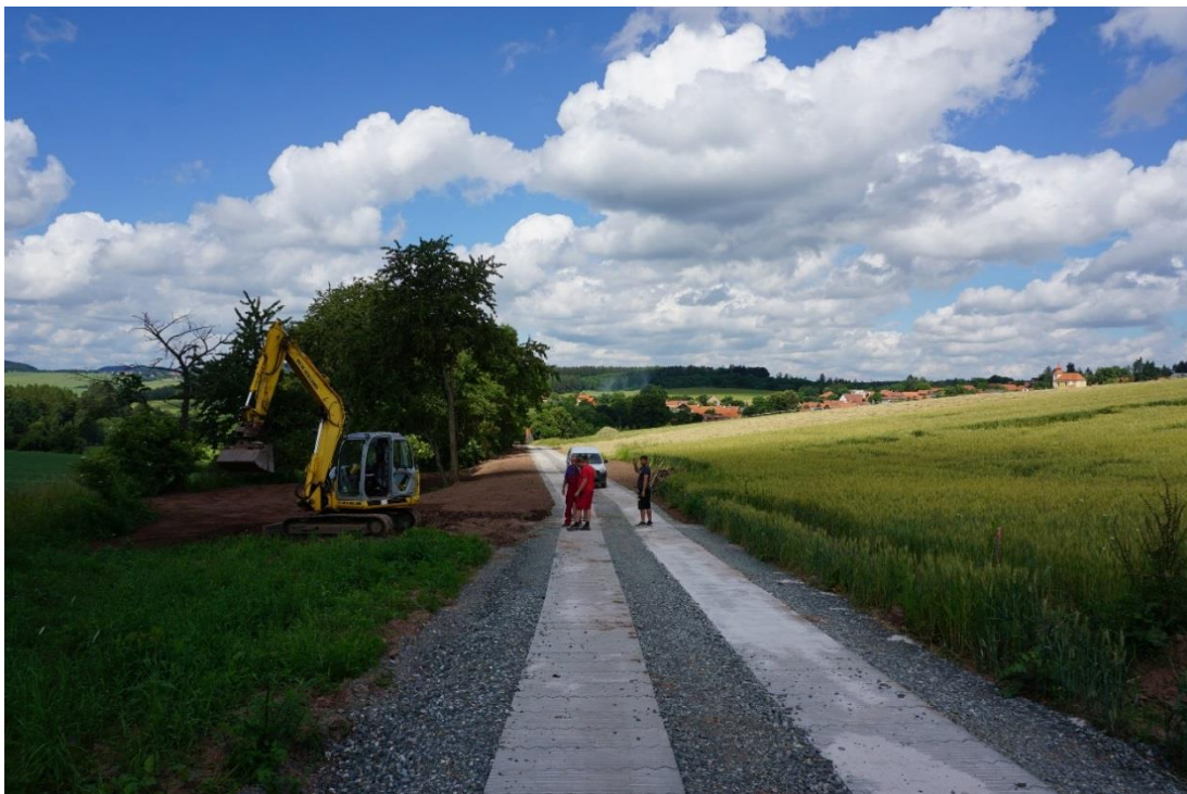
Kolejová polní cesta realizovaná SPÚ, Pobočkou Nymburk
