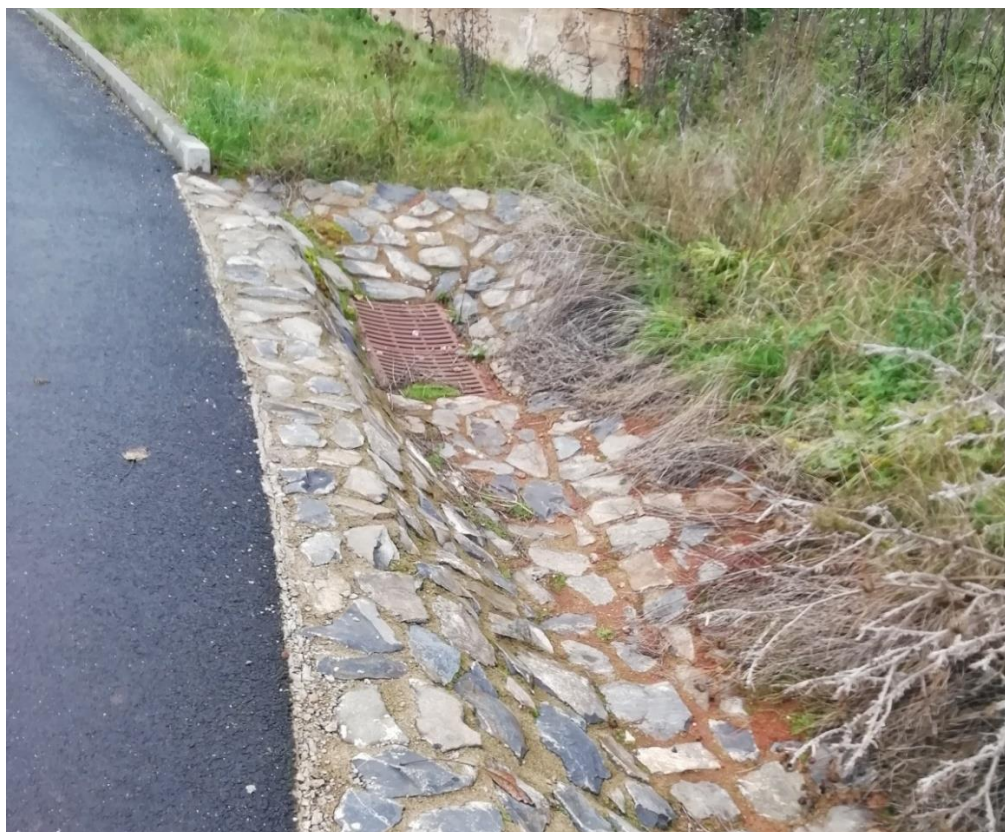
Cesta HC 2 – horská vpust v km 0,120
