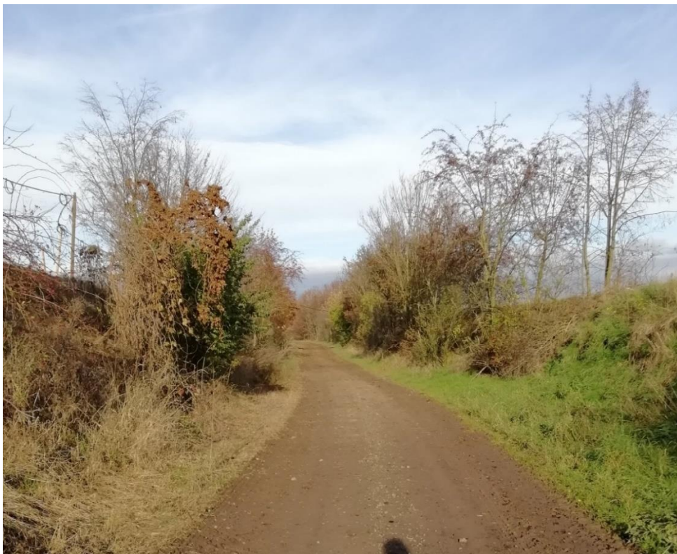
Cesta 1 – stav konstrukce vozovky – pokladní vrstvy stabilní
