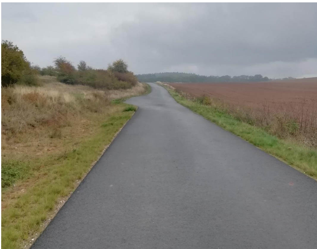
Cesta HC 2 – výhybna, povrch bez známek poškození
