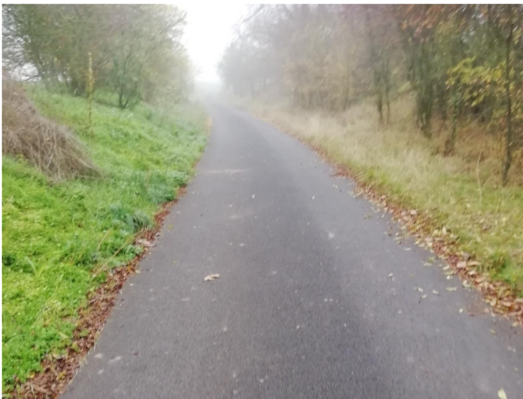
Cesta HC2 – není patrné poškození povrchu
