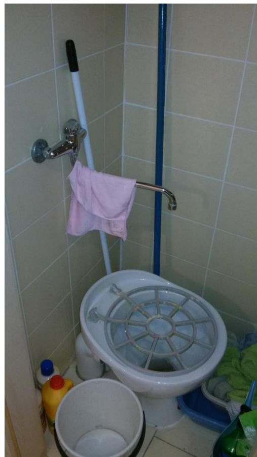
Obr. č. 3 – Úklidová místnost
